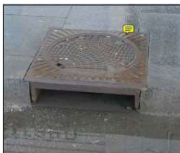
FERDIG MONTERT SLUK I GRANITTEDEKE
