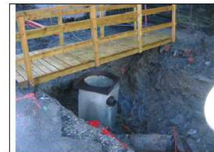
BUNNPLATE MONTERT PÅ KUM Ø650
