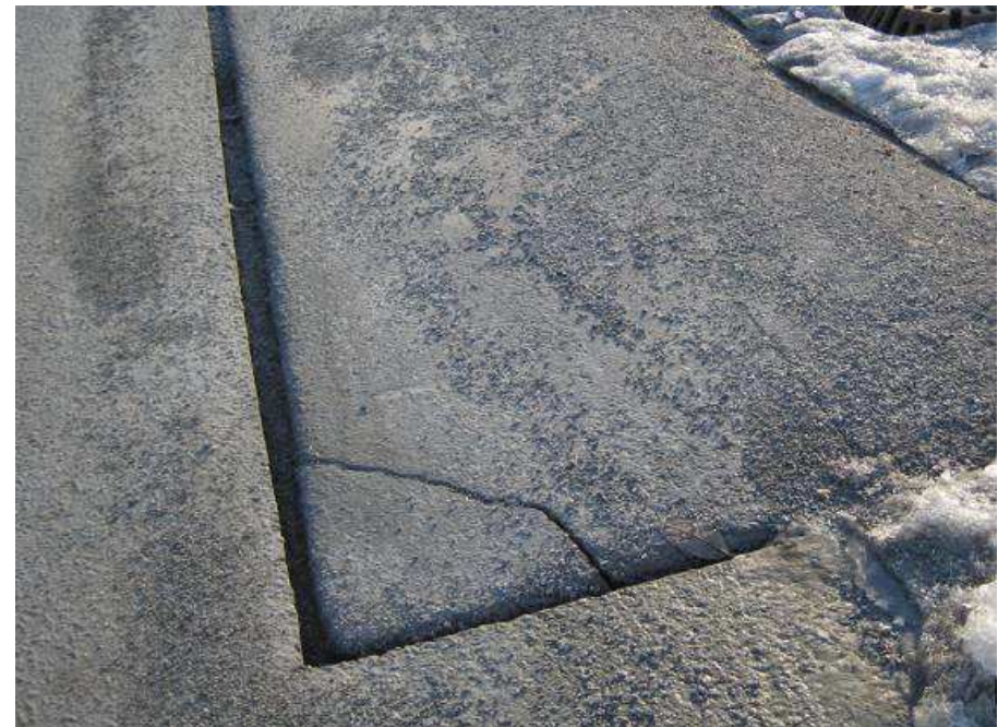
Åpen skjøt pga. manglende klebing og fortanning.
