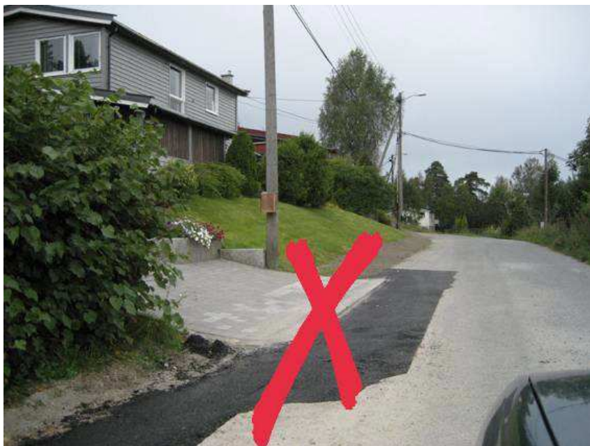
Uønsket endring av grøftetrase.
