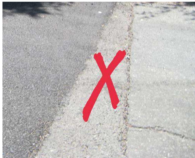
Minst 5 meter til neste skjøt.
