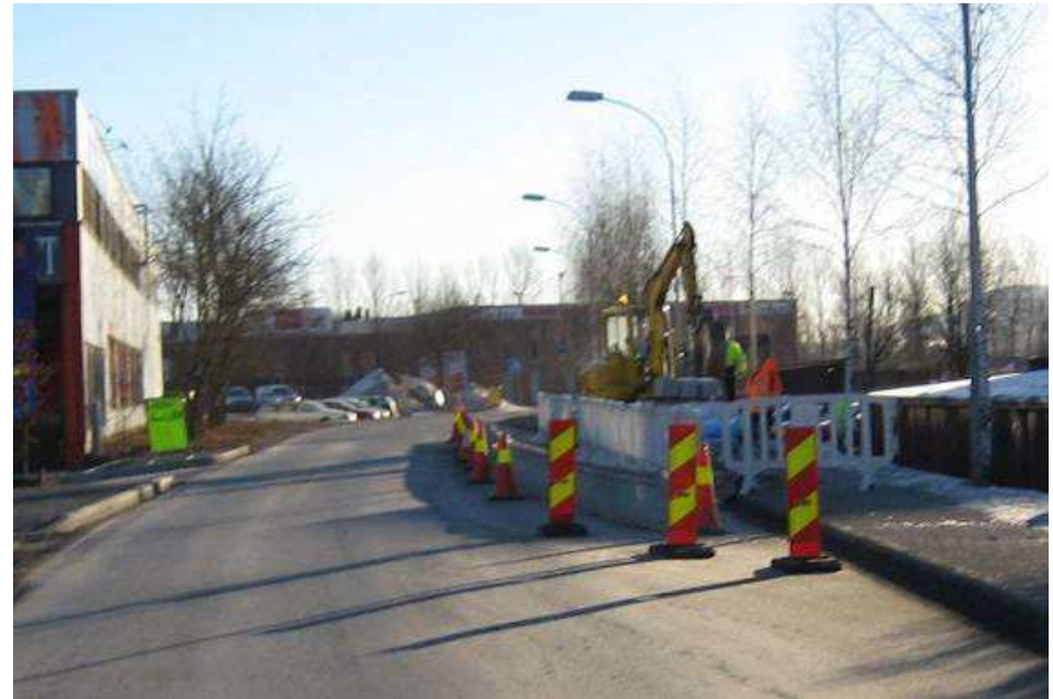
Riktig utført sikring og varslings.
