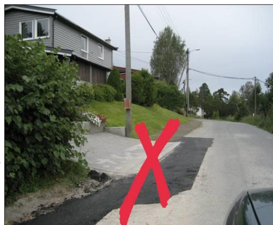
Uønsket endring av grøftetrasé
