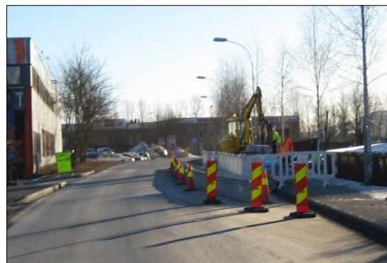
Riktig utført sikring og varsling.
