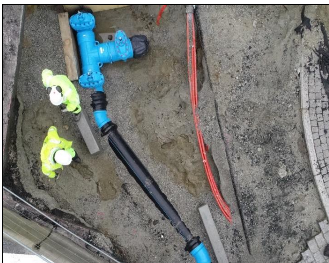
Bilde 2.4. Plastrør i PE under legging (dronebilde i sentrum)
