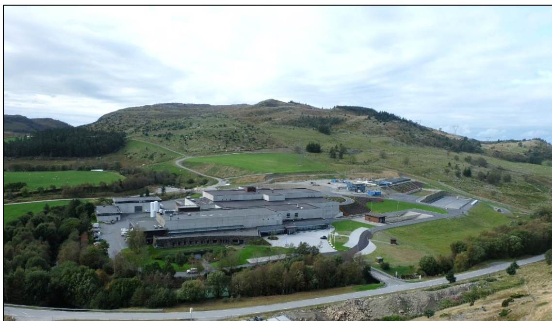
Bilde 2.1. Nytt vannbehandlingsanlegg på Langevatn (Foto IVAR IKS)
