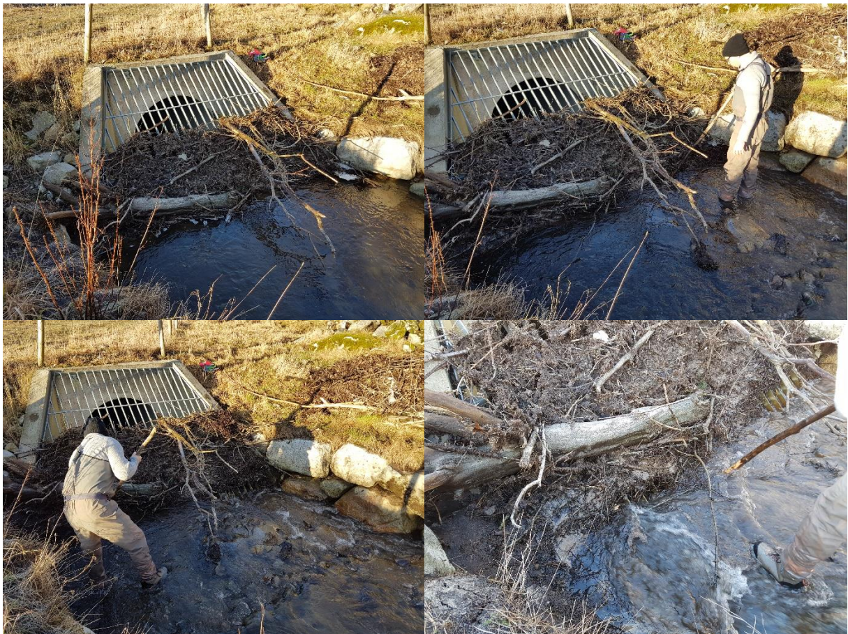
Figur 0.25: En ansamling av greiner og finstoff tettet vandringsveien for fisk fullstendig. Vannstanden sank raskt med 25 cm da vi åpnet «sperringen» ved undersøkelsen i januar 2017. Foto: Rune Søyland.
