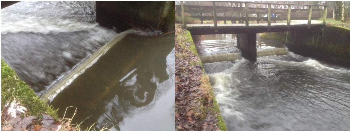
Figur 0.2: V: Fra terskelen er det kort fall ned på flat betong, med manglende vannsøyle for fisken å svømme i, og manglende spranggrop. Meisling av hull i betongflate kan i kombinasjon med ny terskel nedstrøms utbedre vandringshinderet. H: Ny terskel bør plasseres nedstrøms dagens for å heve vannspeilet under terskelen. Det finnes flere muligheter for løsning.
