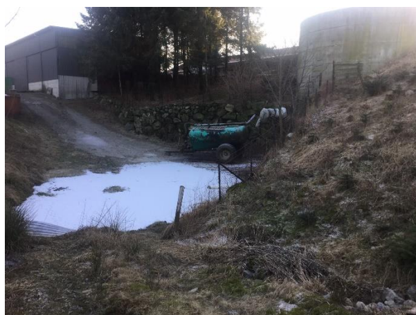
Figur 2. Forsenkningen utenfor gjødseltanken vil hindre et uhellsutslipp i å renne langt og nå vassdraget. Risikopunkt nr. 3.
