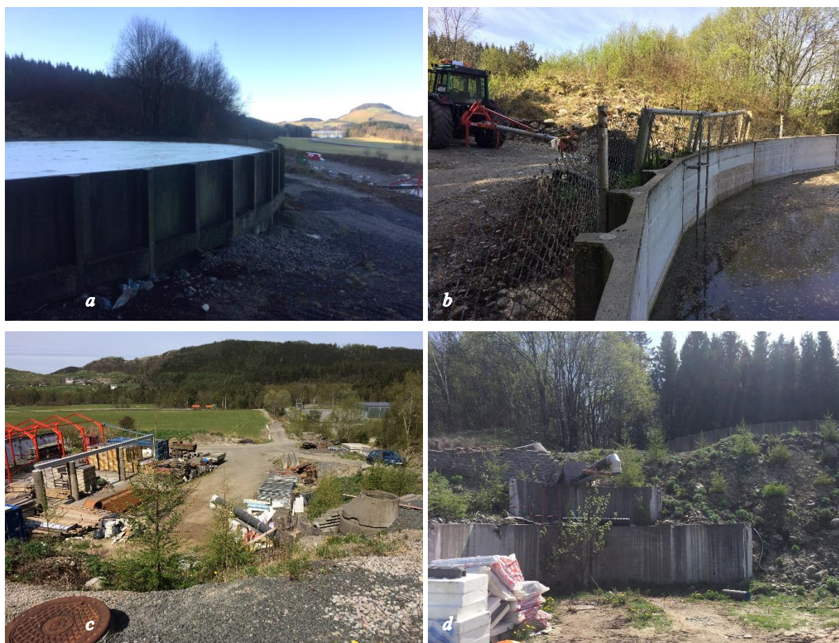
Figur 1. Gjødseltank 1 med avrenning mot Tjessebekken. a) Vinter 2017 var fyllingsgraden i overkant av hva som er forsvarlig. b) Sikring av stigen ned i tanken består av kort gjerde og port lent inntil kanten. c og d) Uttak fra tanken skjer gjennom rør fra bunnen av tanken og ut mot lagerplassen. Risikopunkt nr. 2.
