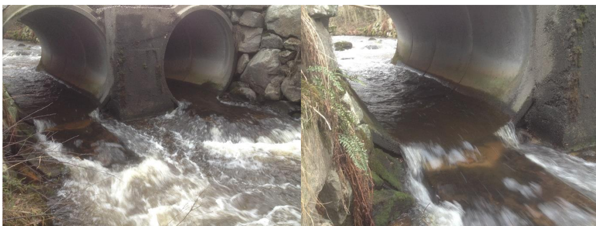
Figur 0.19: Vandringshinder under Melsheiveien. Den enkleste måten å utbedre hinderet på er å lage en terskel nedstrøms rørene for å heve vannstanden under rørene noe, og vil gi fisken mer vanddyb å svømme i. Foto: Rune Søyland.
