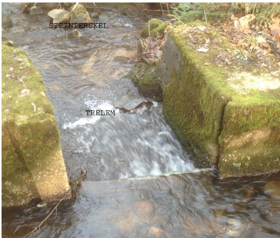
Figur 0.44: Vandringshinder 1 vil være enkelt å utbedre ved å heve vannspeil litt ett eller to trinn. Dersom det er mulig å bore fast en trelem på ca. 20 cm høyde nederst under betongelementet, og heve vannspeil nedstrøms dette med ca. 20 cm ved hjelp av en håndlaget steinterskel, vil fisken lett passere på de fleste vannføringer.
