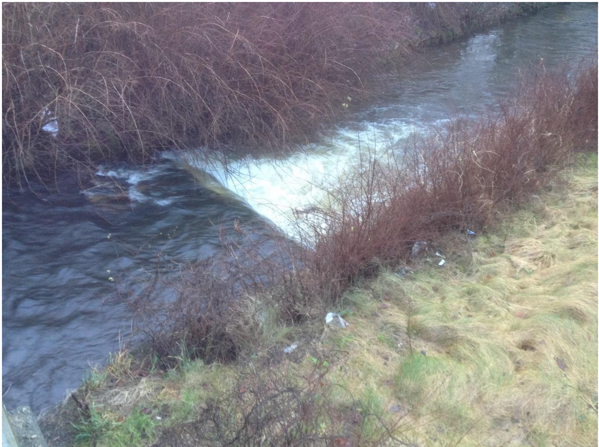
Figur 0.36: Hinder 9 i sone 22 i Storåna. Flat betongterskel som særlig ved mye vann danner det høyeste fallet i hele Storåna. Fallet er mindre ved lav vannføring, men kan fortsatt være problematisk for mindre fisk.
