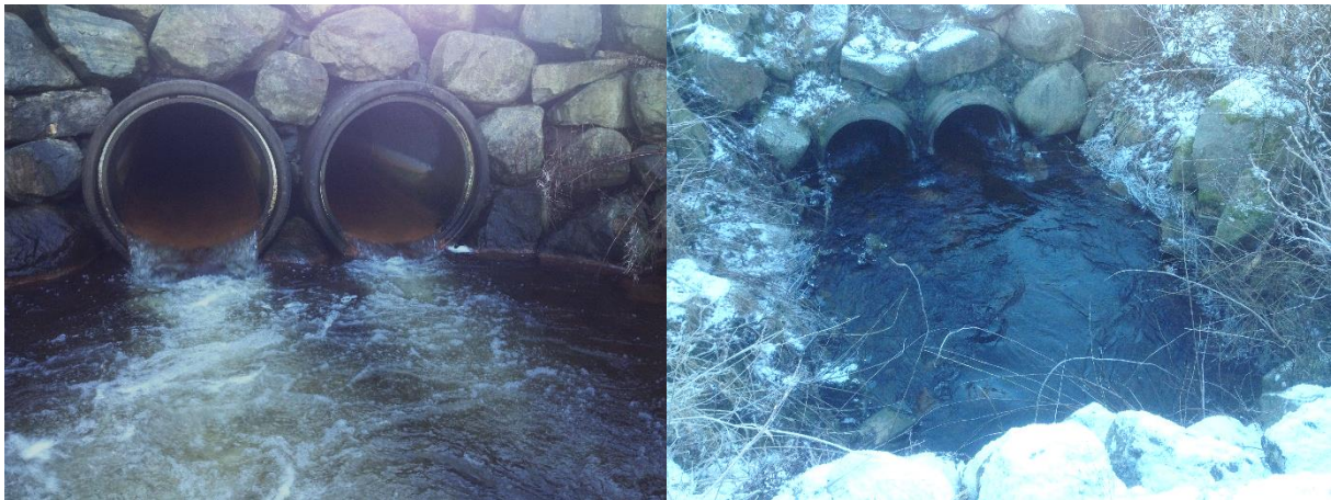
Figur 0.21: Vandringshinderet i sone 30 sett fra utløpet (venstre) og innløpet (høyre). Utplassering av tilpasset steinblokk til høyre for rørutløpet kan sikre ål inngang til et rør. Det er viktig at spranggroppen for anadrom fisk samtidig bevares. Utplassering av blokker et stykke foran rørinnløpene kan bidra til å styre mer vann i det ene løpet, og forhindre at greiner og kvister tetter rørene. Foto: Rune Søyland.
