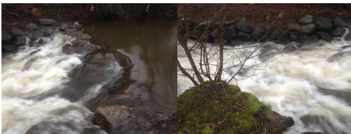
Figur 0.6: Langstrakt steinterskel under dam ved Skeilunden. Vandringsmuligheten er trolig styrt av vannføringsforhold, og terskelen er trolig stengsel for mindre fisk.
