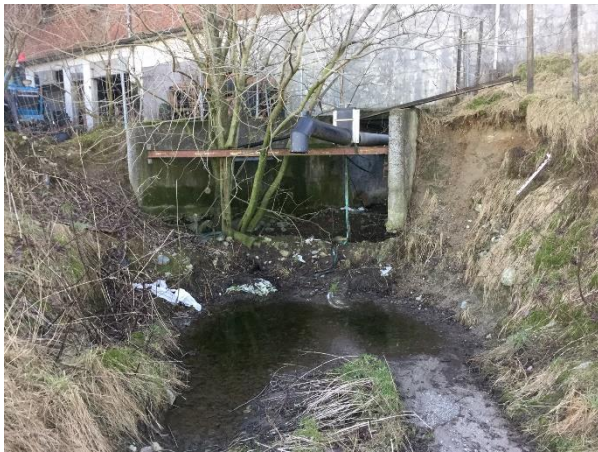
Figur 3. a) Et eksempel på en gjødselkjeller med lukeuttak. Et eventuelt uhellsutslipp her vil først samles opp i forsinkingen like utenfor. b) Dernest vil det renne nedover marka til det stopper i enden hvor det er ei grop. Det er fortsatt god avstand til åpent vann og det meste kan derfor samles opp.
