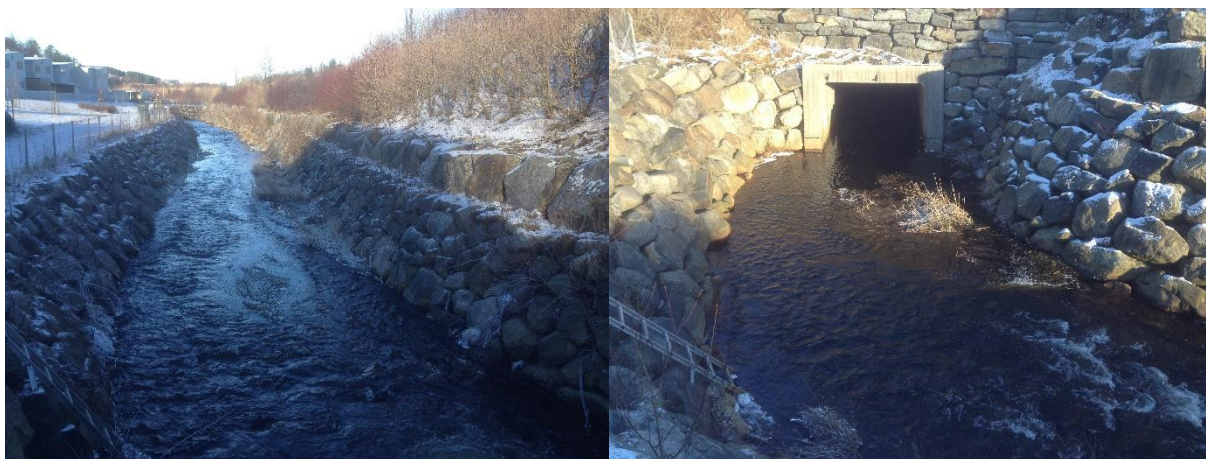
Figur 0.51: Venstre bilde viser øvre del av sone 29, mens høyre viser nedre del før elva renner inn i kulvert under E-39.
