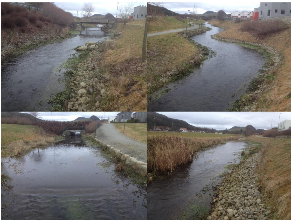
Figur 0.49: A: Nedre del av sone 26 ved Brattabø. B: Det er i store deler laget slake kanter, og det er brukt grov elvegrus til reetablering av bunn. C: Nærmest i bildet skimtes flat steinterskel nedenfor et litt bredere parti. Ved liten til middels vannføring blir det svært lav vannsøyle over hinderet, og nedvandrende smolt kan potensielt hindres. Opphold i nedvandringen fører ofte til økt dødelighet. D: Dyrkamark øverst på østsida har ingen funksjonell kantvegetasjon, og steinsatte kanter.
