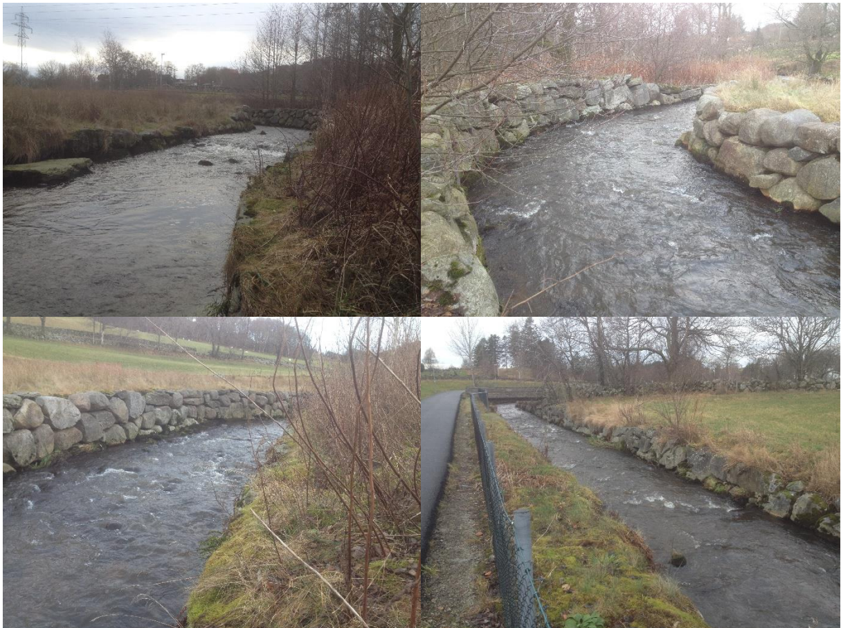
Figur 0.47: A: Nedre del av sone 17, hvor det potensielt kan legges ut gyttegrus. B: Steinsatte kanter i sone 17, nedre del. C og D: Steinsatte kanter og mangel på funksjonell kantvegetasjon.
