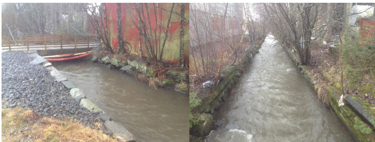
Figur 0.31: Sone 18 er sterkt påvirket av omlegging, kanalisering og steinsetting, i tillegg til at kantsonene er sterkt påvirkede. Foto: Rune Søyland.
