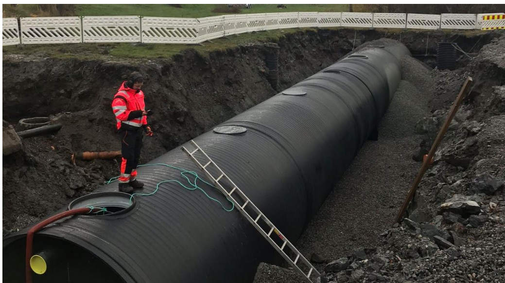
Figur 4. Oversiktsbilde slamskullerlegg i PE, 30 meter langt og 3 meter i diameter.
