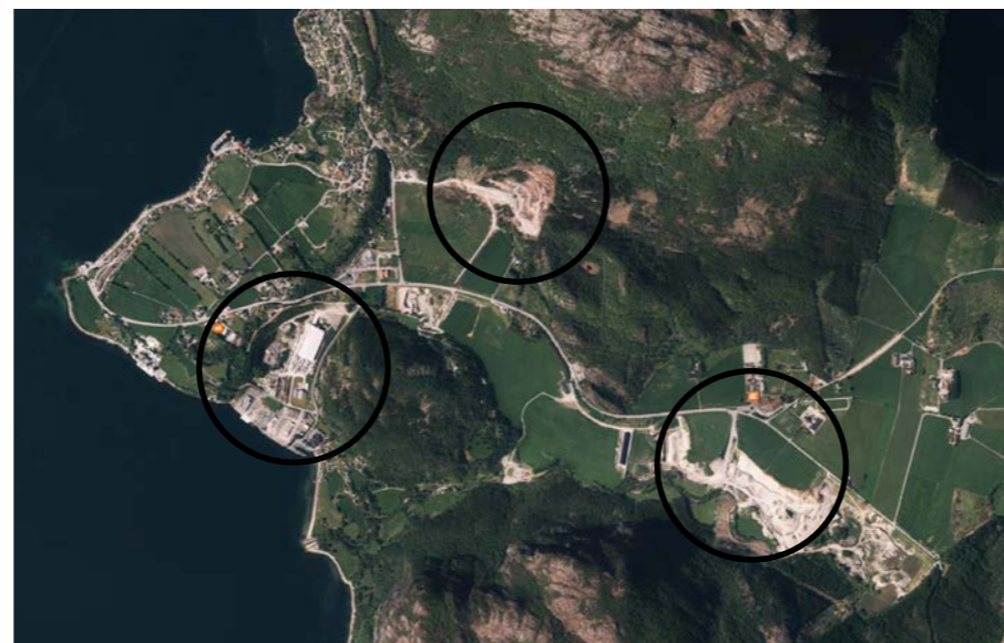
2013. Sanduttak i syd har flere bygninger, flere veier opp mot fjellsiden i nord
