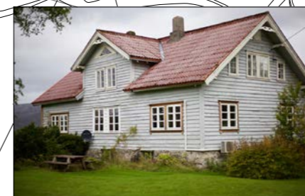
4. Kyrkjevegen 57, ca 1870 Sveitserstil med utskjæringer på bjelkehoder, mønebord og i møne.
