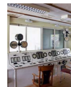
Industri som kulturminne; fra kontrollrommet på Flørli
