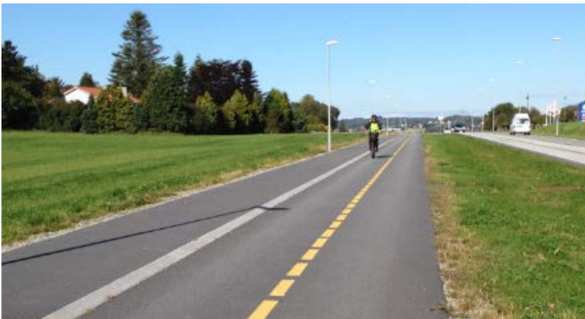
Figur 16. Sykkelveg med fortau langs fv. 443 Forusbeen (Foto: Ingve Undheim).
