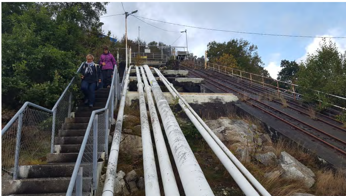
Fig 14: Trapp og skinnegang til ilandføringskaia
