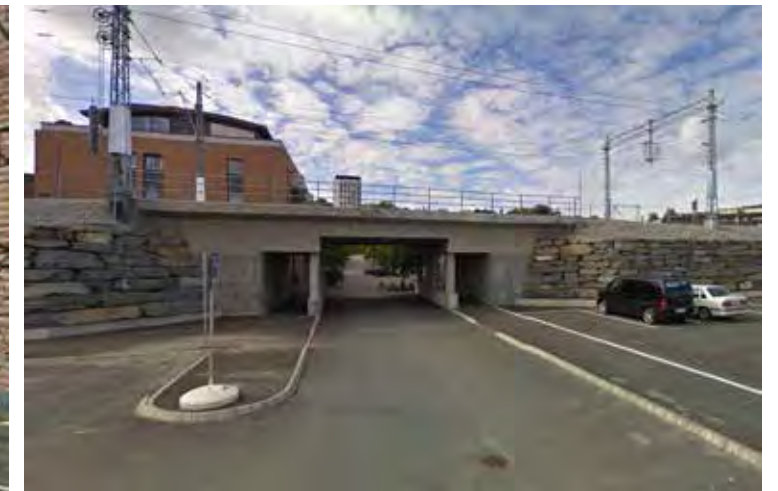
Undergangen i Gandsgaten, Bredde bilvei 6,8m, fri høyde 3,7m
