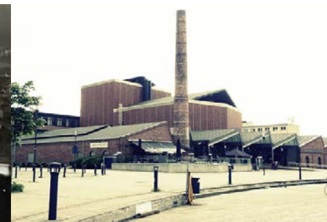
Transformasjonsbygg - Kulturhus Sandnes
