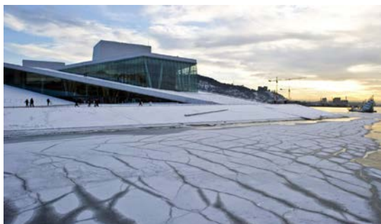
Flaten beskytter mot vannstigninger som del av plassens design.
