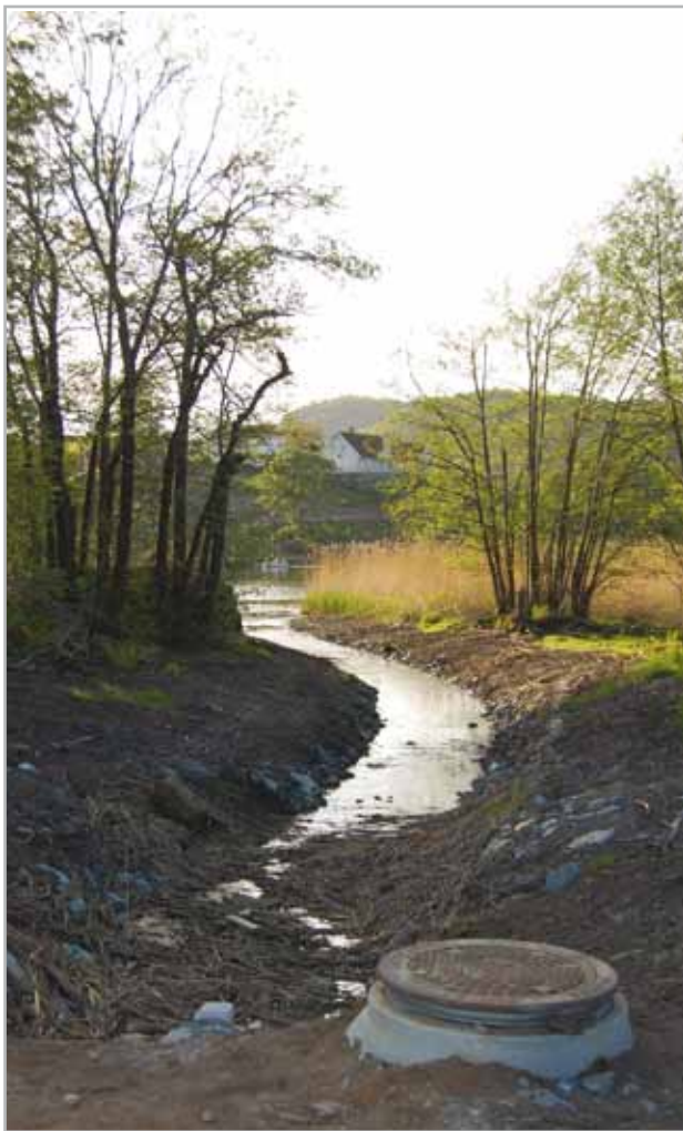
Krossvatnet, Tau. Bekkeløp reetablert i forbindelse med vegarbeid (Foto: Kjersti Tau Strand).
