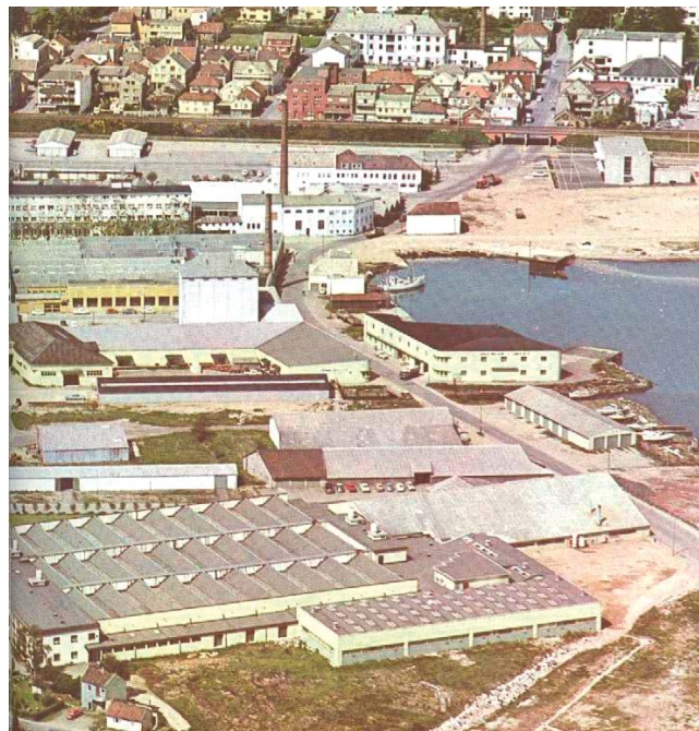
Arkitektur av god kvalitet ble bevisst brukt av industrieierne i merkevarebygging. Gustav Helland var arkitekt for flere signalbygg i Sandnes på 1930- og 40 årene. Bilde viser "Øglændbyggene" i Havnegata 4 og 5 på slutten av 1950-årene
