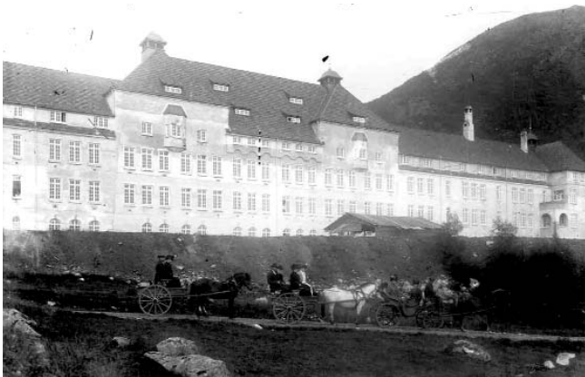
30 Eldre detaljbilde, mannsavdelingen Dale sykehus(1911-13) tegnet av arkitekt Sigurd Lunde. (Fotograf J. Dahle . Utlånt fra Statsarkivet)
