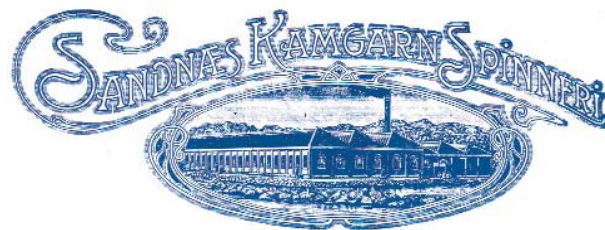
Fasaden på det tidligere industribygget Sandnes Kamgarn og spinneri fra 1899 har gitt utforming til Kulturhuset, som åpnet i 2000.
