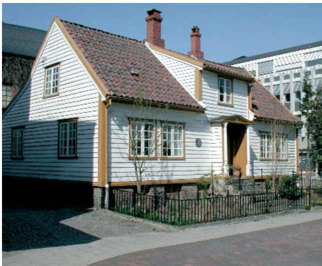
Nyårdshuset i Langgata fra 1837 ble vedtaksfredet i 1941. Midtgangshus med søylebislag inspirert av klassiske portaler som er karakteristisk for Sandnesempiren
