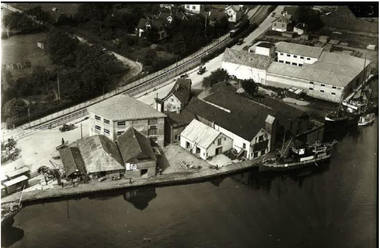
Damskipsbrygga under omforming på 1935. Strandgata er nå lagt utenom langs jernbanen, og huset, som ble kjent som ekspedisjonsbygget til J. Schanche Olsen, er kommet på plass. Deler av den gamle bebyggelsen på «Strandneset» står, i dag er alt borte. (Foto Widerøe)
