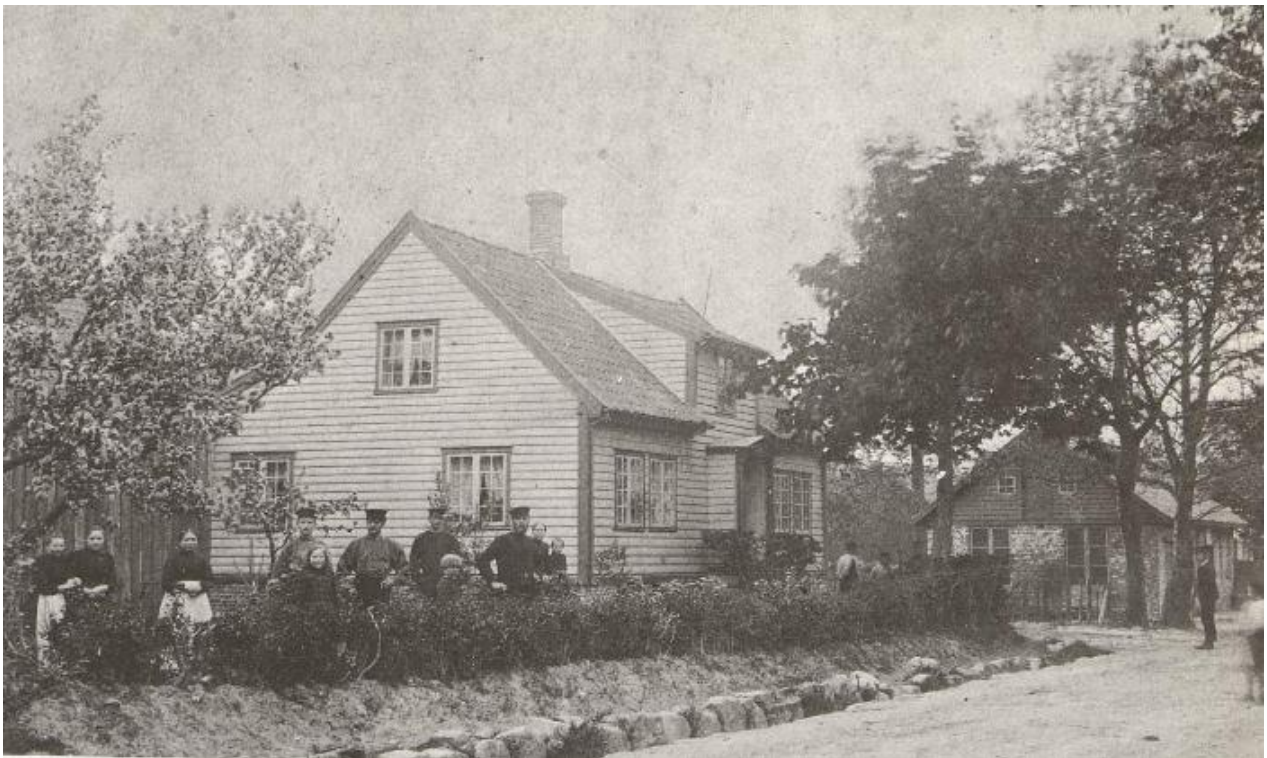
Det fredede Nygårdshuset i Langgata – det eneste bevarte hus i sentrum fra før bydannelsen. Bygd av smeden Bendik Osmundson 1835. Smia ses i bakgrunnen. Huset ble fredet i 1941. (Bildekilde «Bilder fra gamle dager» Sandnes 1976.
