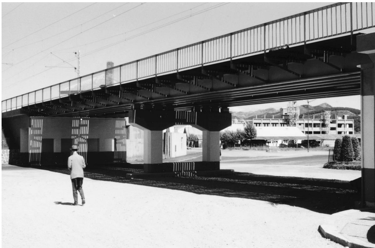
Oalsgate ble anlagt i etapper utover 1900-tallet, fotoet viser jernbaneundergangen ved Elveplassen i 1959. Høybanens undergang er utformet i tydelig og kraftfull etterkrigsmodernisme, er lite endret og gjør det lett å knytte anlegget til epoken. (Foto Norsk jernbanemuseum)
