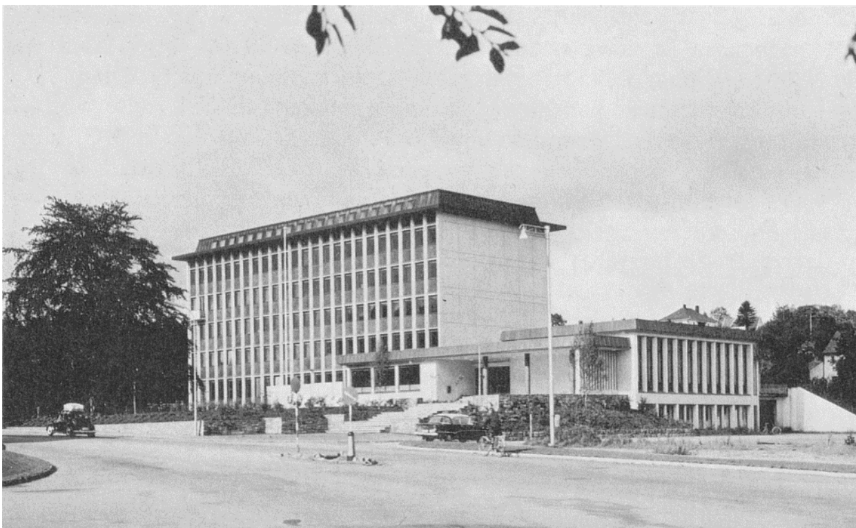
Høyland nye rådhus på Skeiane fra 1961. En av Sandnes mest velformede representanter for etterkrigs modernismen, der arkitektur og forhage med terrassert inngangsparti utgjør en helhet. Arkitekter var Gustav Helland og Endre Aarreberg.
