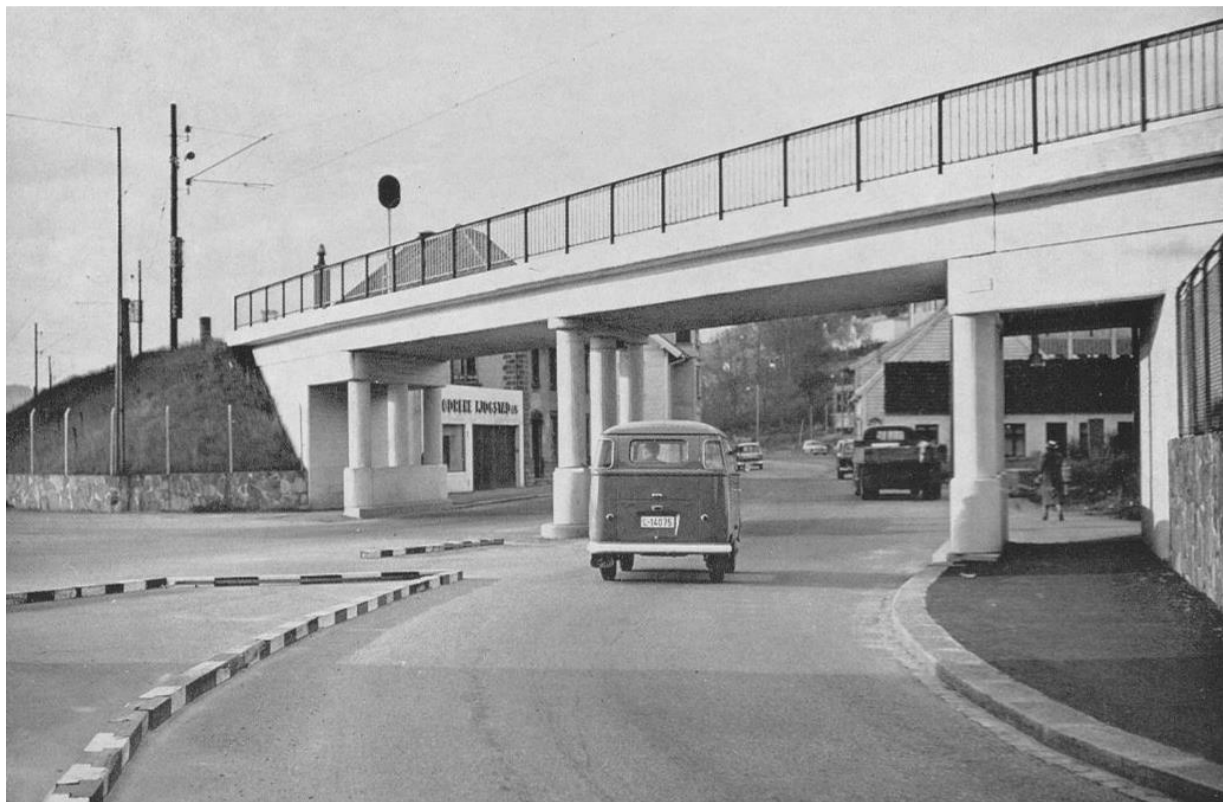
Høybanen som ny, i bro over riksveien ved Kaien, fotografert 1960. Høybanen var et prosjekt med påkostet utforming – skiferkledd murverk, smijernrekkverk og fint formede underganger i moderne stil. Undergangen til hovedveien spiller tidens brytning mellom nyklassisisme og funksjonalisme. (foto Alf Hobbessland)
