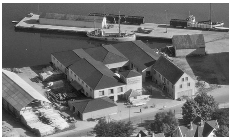
Det gjenstående lageret med saltak til høyre dannet utgangspunkt for den ene fløyen i oppbyggingen av hesteskoen etter brannen i 1933. Det nye høvleriet befinner seg i motsatt fløy mot gaten, med mer lager mot sjøen. «Tårnbygningen på gårdsplassen er et spønhus – et lager for trespon, som var fint å fyre opp med i tiden da man brukte vedkomfyr.
