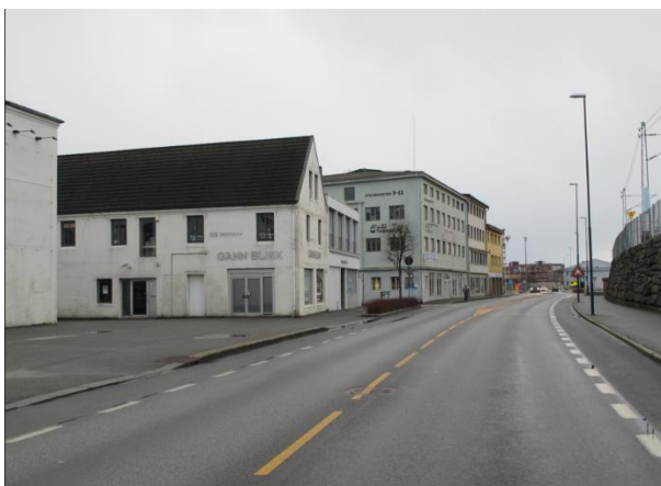
Mot Strandgata 15, det eldste Fjogstad-huset. Deretter tollboden fra 1964 og Øglænd og Block Watnes store lagerbygg fra 1937.
