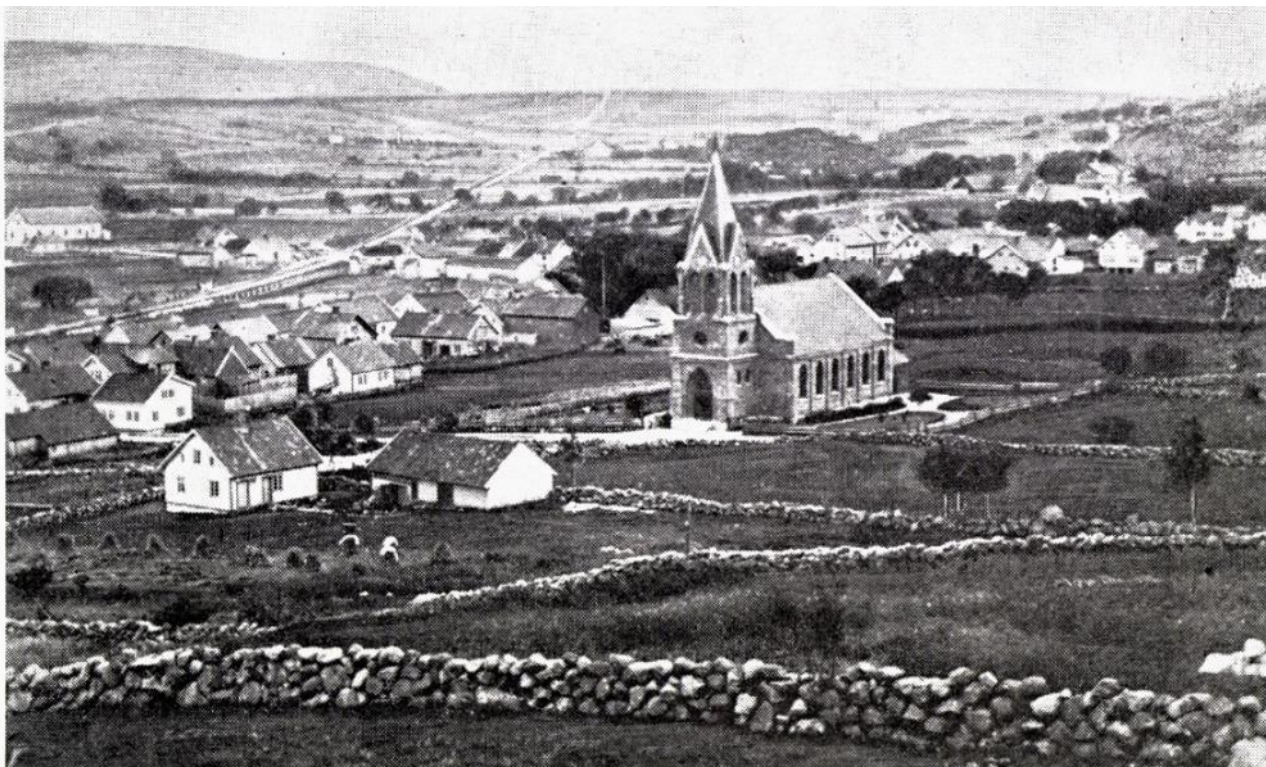
Sandnes kirke fotografert like etter at den ble bygd i 1882. Den ble reist på flinterbakken, på plassen Hagen gitt av Gabriel Jonasens arvinger. Dette er før Ole Jacob Brochs gate og før Kirkegata 8 ble bygd. Det hvite huset med skeivt takløft er Kirkegata 6. Byen var omgitt av grønne marker opp til Trones. (Digitalt museum JÆHS004.241).
