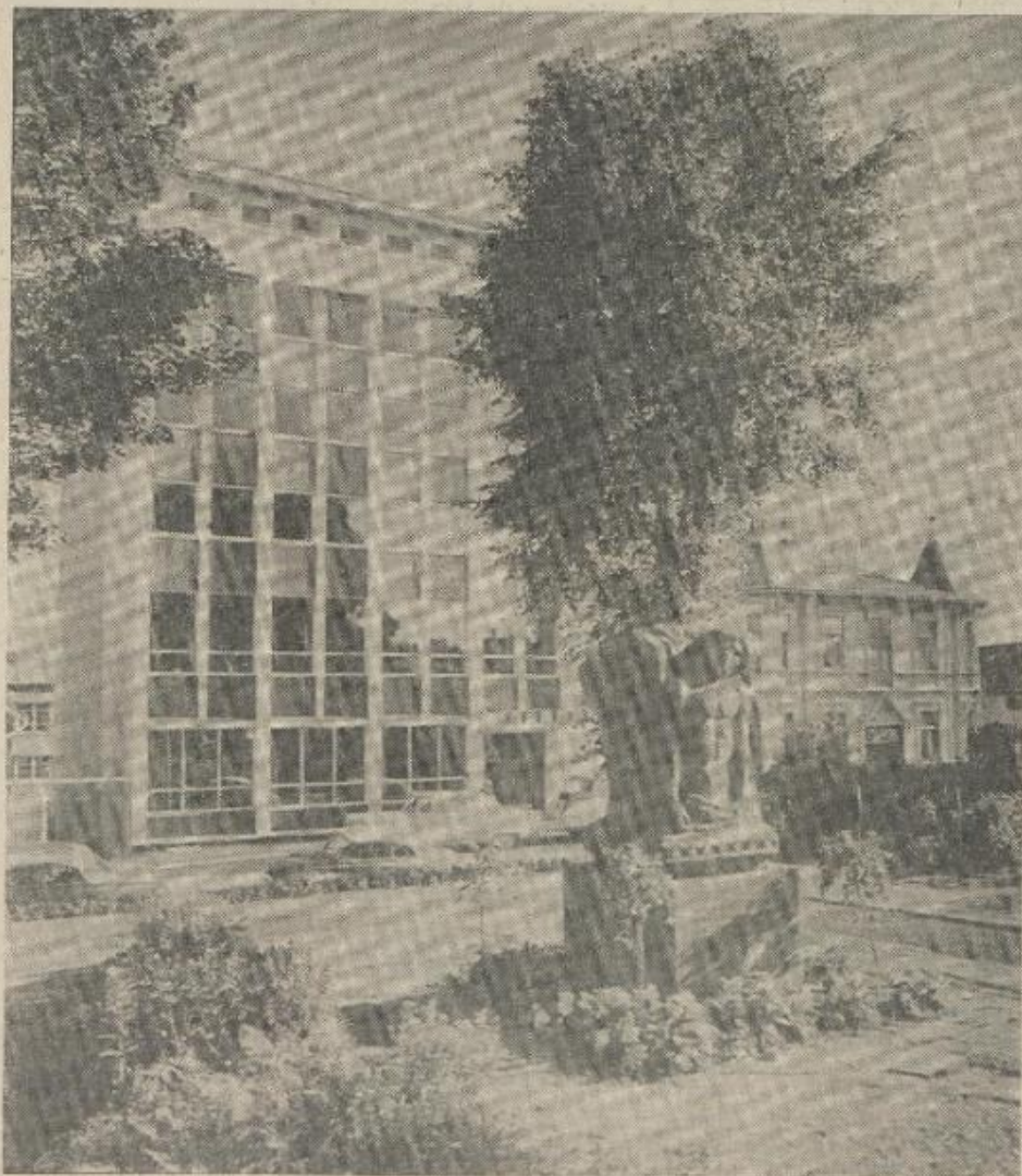
Det nye og det gamle. Nybygget ruver svært over det som hittil har vært Hotel Sverre (til høyre på bildet). Ennå er det ikke bestemt når det gamle skal rives og 2. byggetrinn som skal romme restaurant og selskapslokaler, vil bli påbegynt. Arkitekt for bygget er K. K. Grødeland.
