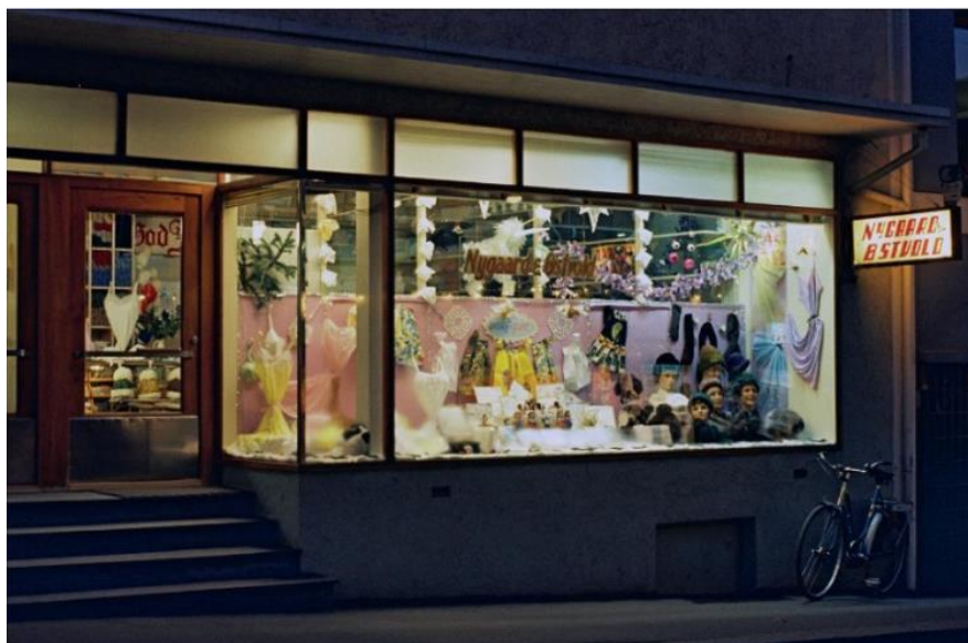
Nygaard og Østvolds butikk i Flintergata. Det lave murhuset ligger på eiendom matrikkulert under Langgata 24, men ligger til Flintergata. Det ble bygd av Per Ellingsen i 1953 (JSJ 1965:517) (Bildekilde Hall Næsheim 2022:52). I dag holder «antik&auksjon» til her.
