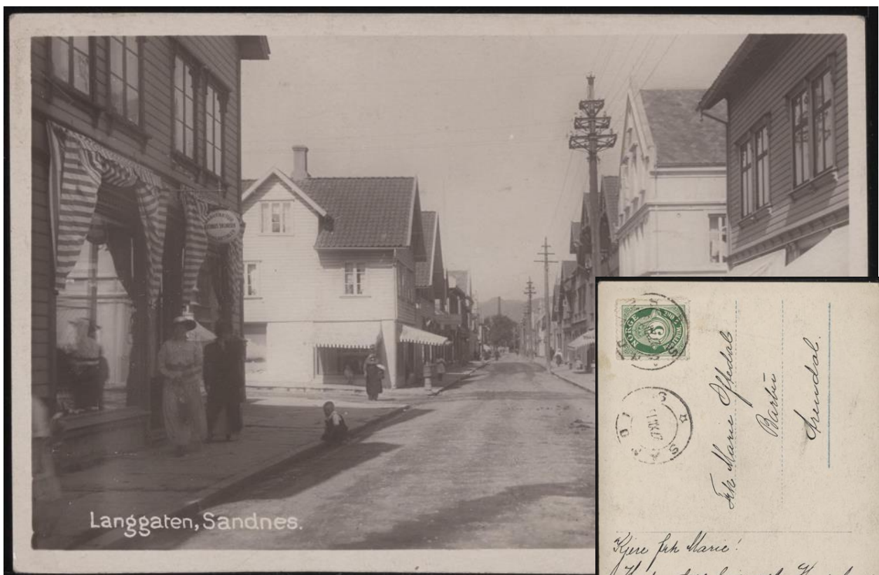
Postkort med motiv fra Langgata nordover fra Flintergata. Brolegging av sentrumsgatene med gatestein kom sist på 1920-tallet, først på strekningen Krossen – Langgata 74. Det var fortauene som først fikk fast dekke. De ble belagt med store hardangerheller i perioden 1886–1910.
