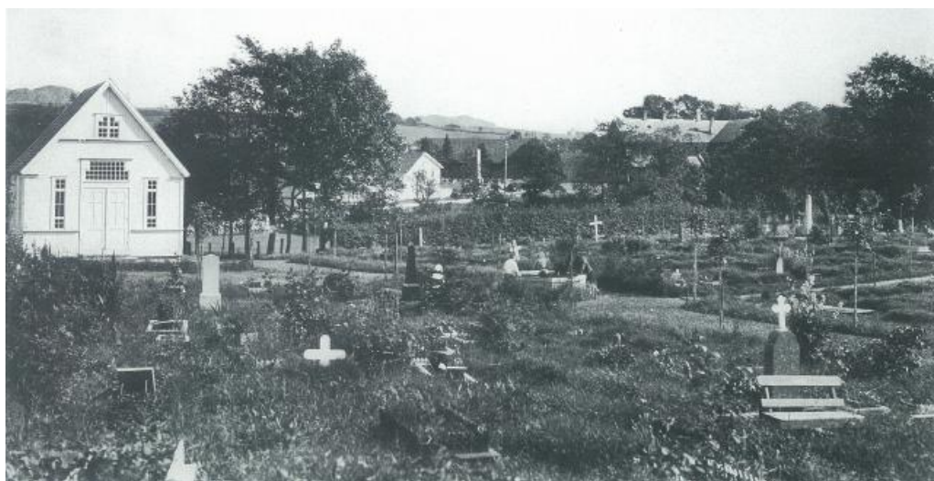
Ludvig Ludvigsens foto over Sandnes kirkegård fra heftet «Sandnes 1924». Bak den innerste trerekka, som fortsatt står, skimtes Høyland bank og kommunelokale. Bråstens barkemølle er skjult bak trærne til høyre.
