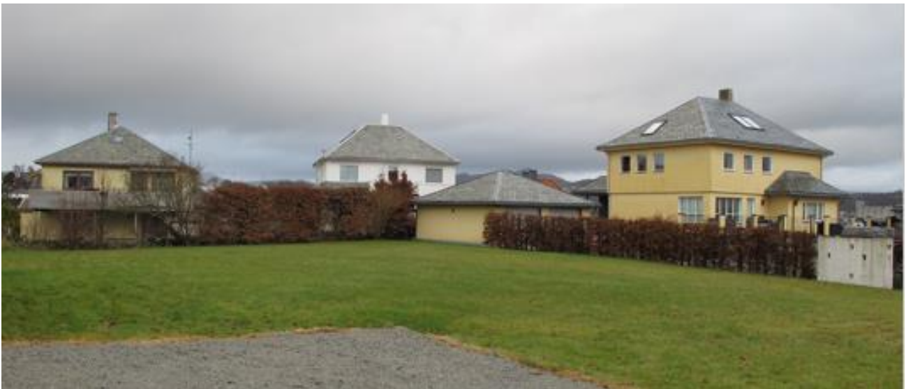
Mellom Aleksander Kiellands gate og Jona Lies gate ligger en gruppe bolighus i mur bygd rundt 1939. De har et enhetlig og tidstypisk uttrykk, stilhistorisk kan uttrykkes som en overgang mellom nyklassisisme og funksjonalisme. De brede, skifertekte valmtakene setter preg på mye av tidens arkitektur i Sandnes.
