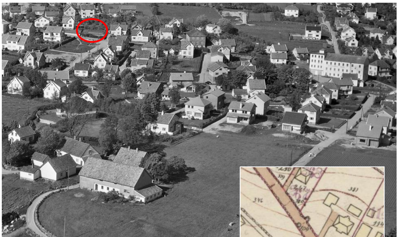
Oalsollen, den viktigste kilden til Oalsbekken lå ved dagens nr. 57 i Solaveien. Her markert med rød ring. Kilden er også tegnet inn på utskiftingskartet over Stangeland fra 1927-28, innfelt til høyre. I forkant av Widerøefotoet fra 1959 ses et av hovedbrukene på Stangeland («Lavabruket»?)
