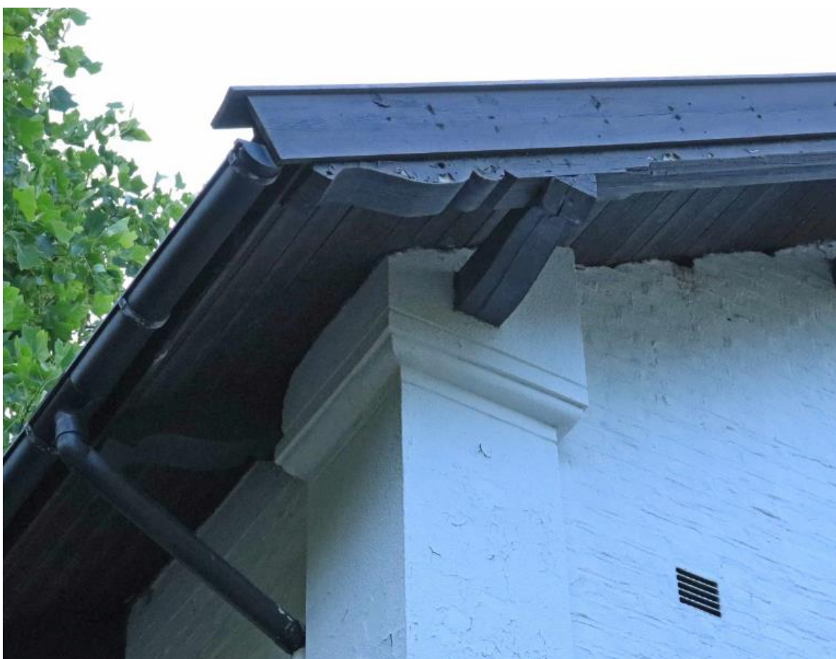
Bevarte detaljer: Sveitsertak. Hjørne markert med pilaster. Gesimsbånd mellom etasjene. Buen i det «palladianske motivet» syns så vidt.
