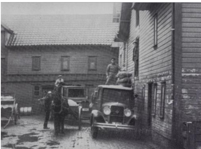
Gårdsplassen med de gamle lagerbygningene fotografert i 1932. Hestekraft og motorkraft i skjønn forening gir et representativt tidsbilde av en lang overgangssone mellom de to transportformene. Utover i 1930-årene kjøpte foreningen inn to lastebiler. (MW 2007)
