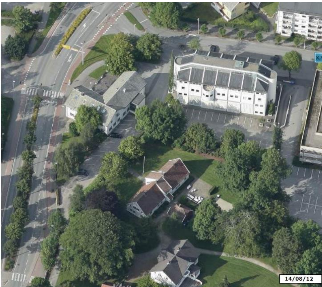
De gamle hovedfasadene er i dag blitt baksider. Her er det vel et potensial for oppgradering?
