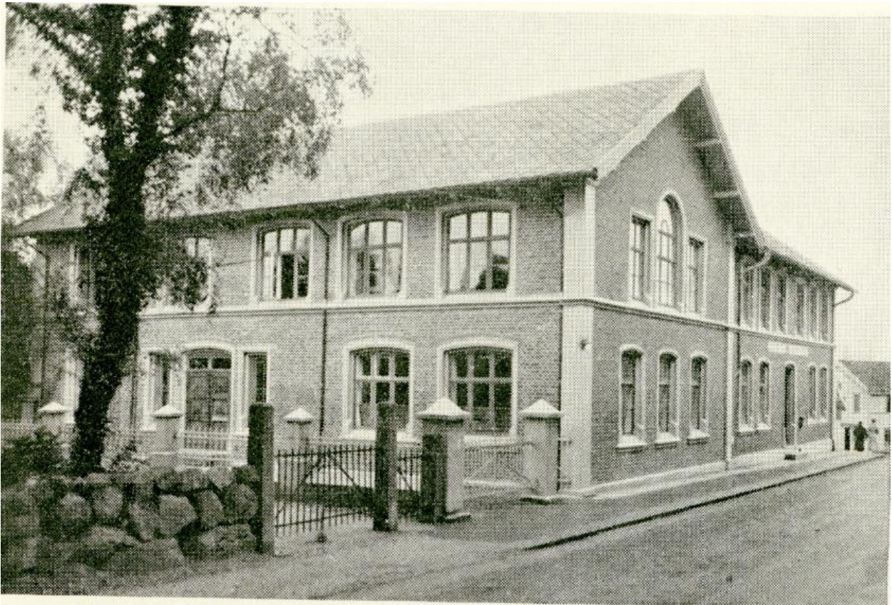
Etter tilbygget 1911. Festsalen i 2. etasje synes godt for reisende på Jærveien (retning nord), med store vinduer gruppert og et sammensatt vindu i gavlfeltet utført som et «palladiansk motiv» (også kalt serlianamotiv). Et motiv som ofte ble brukt til å framheve forsamlingsaler som denne, og som var lett «å lese» for samtidens reisende på hovedveien. Motivet gjentas til en grad ved inngangsdøren, som har kraftige fyllinger. (Foto fra Høyland 1837–1937, s. 21)
