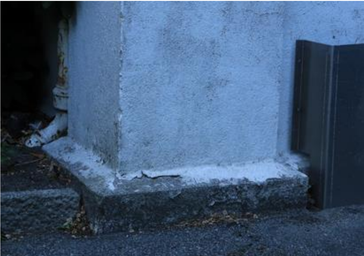
Sokkel for hjørnepilastrene.
