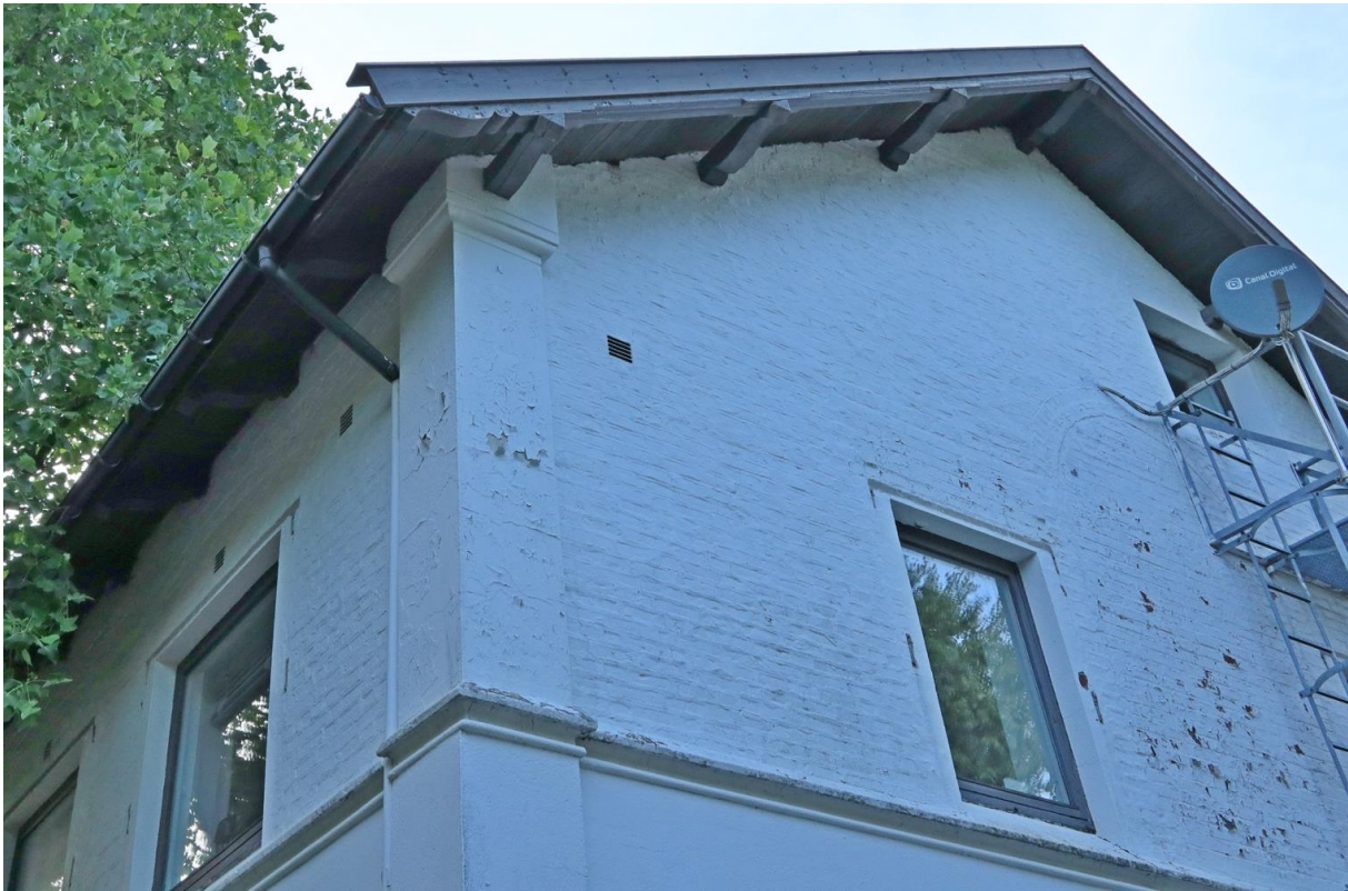
Bevarte detaljer: Sveitsertak. Hjørne markert med pilaster. Gesimsbånd mellom etasjene. Buen i det «palladianske motivet» syns så vidt.
