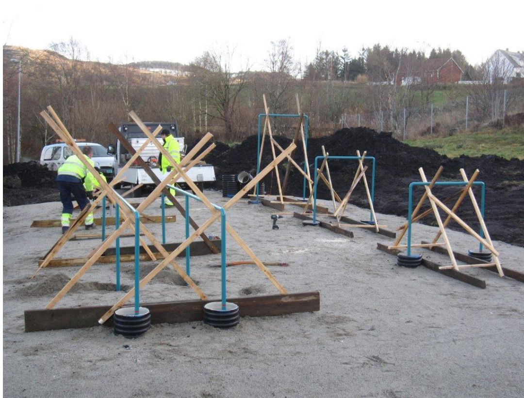
Trimparken som Barn og unges bystyre tildelte kr 25 000 til i 2014 blir montert.
