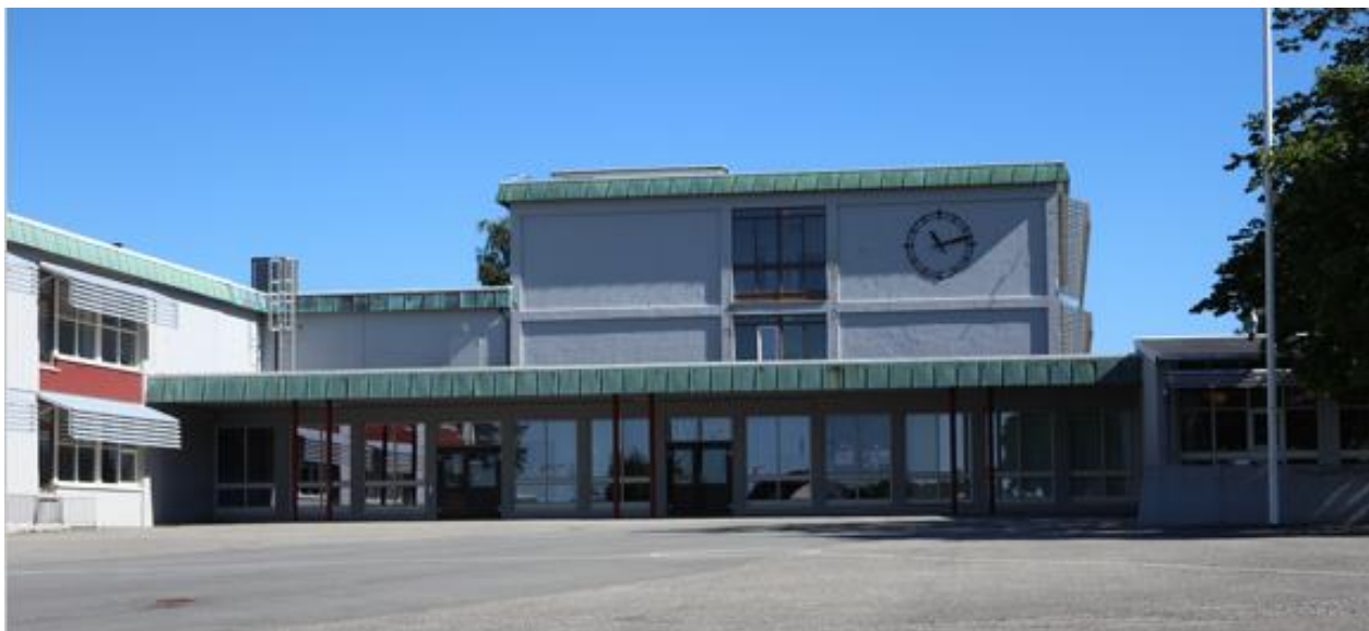
Trones skole, Sandnes nye folkeskole fra 1956, introduserte paviljongsystemet i skolearkitekturen. Prosjektert av Eyvind Retzius.
