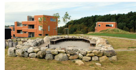
Midt blandt blokkene i Rossalandstunet er det tatt vare på en gravrøys (bak i bildet).
