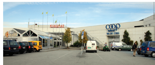
Kvadrat er et av landets største kjøpesentre. Bygd på det som tidligere var Sandnes støperi.
