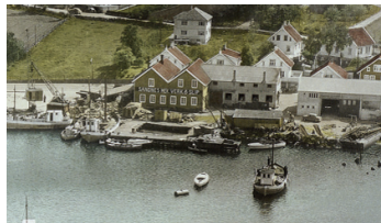
Sandnes mek. Verksted & Slip
