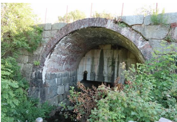
Brua over høylandsåna ved Tronsholen, (Hofbroen) fra 1882, markerer den siste etappen av den moderne chausseen mot Gjesdal. Den er en sjelden og svært fint gjennomført hvelvbru i naturstein, foret med teglstein fra Sandnes. Etter veiomlegging er den bare synlig fra én side. Brua er med på Landsverneplanen til Staten vegvesen.
