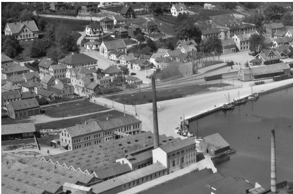
Utsnitt av Widerøe-foto fra 1935. Torvbryggen (Vågsalmenningen) hadde steinkai, men den lå så lavt at flo sjø ofte gikk over. I 1918 fikk den en toppfylling på en halv meter. Bilde viser de tre offentlige plassene i Sandnessjøen – Torvbryggen, Torvet og Stasjonsplassen – før utstillingsplassen til 75-års jubileet ble anlagt i 1935. (ika-w004130_1935)
