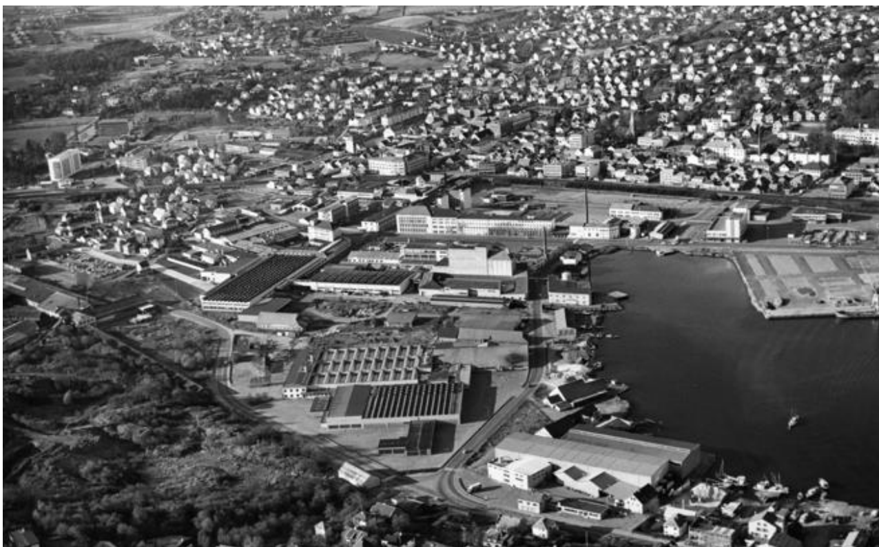
Vågen 1970, i ferd med å bygges helt ut med store, lave industribygninger etter moderne prinsipper om «alt på ett plan» Konfeksjonsfabrikken og engroslager fra 1960-tallet nærmest. (Digitalt museum JÆØF0781)
