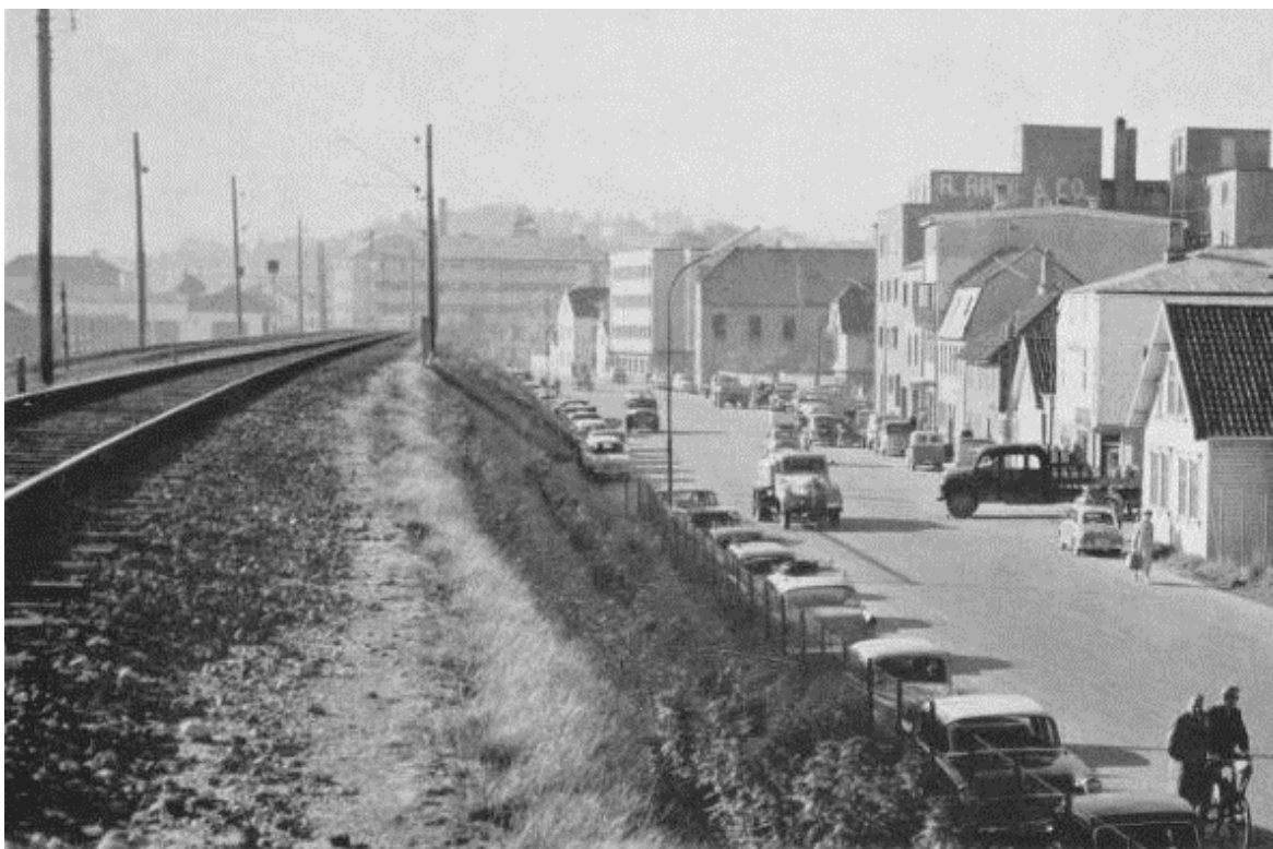
St. Olavs gate ble lagt i det gamle jernbanesporet og skapte en ny gjennomfartsåre på baksiden av sentrumskvartalene. (Foto Gabriel Bore, 1960)
