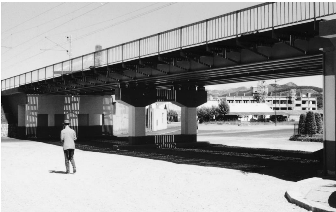
Oalsgate ble anlagt i etapper utover 1900-tallet, fotoet viser jernbaneundergangen ved Elveplassen i 1959. Høybanens undergang er utformet i tydelig og kraftfull etterkrigsmodernisme. Den er lite endret, det er fortsatt lett å knytte anlegget til epoken det ble bygd. (Foto Norsk jernbanemuseum)
