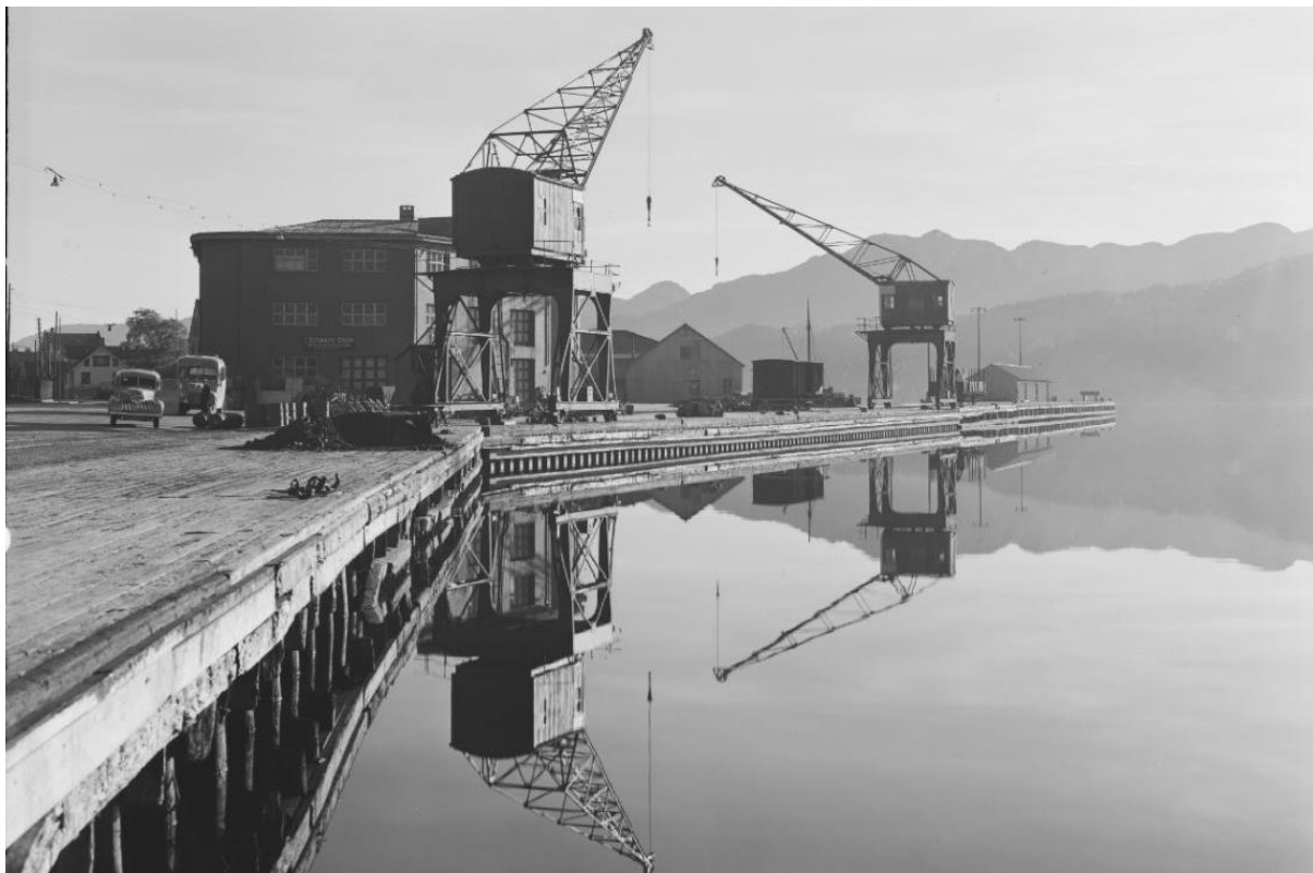
Morgenstemning på Kaien, fotografert av Normanns Kunstforlag (tatt etter 1937 og før 1951 da Strandgata 7 ble bygd). I 1930 ble det kjøpt inn to beskjedne svingkraner. Etter krigen overtok Havnevesenet to portalkraner fra tyskerne, noe som framskyndet bygging av en mer solid betongkai. I 1976 ble løftekapasiteten vesentlig utvidet med to nye kraner – de som står i dag. (Nasjonalbibliotekets bildearkiv.)
