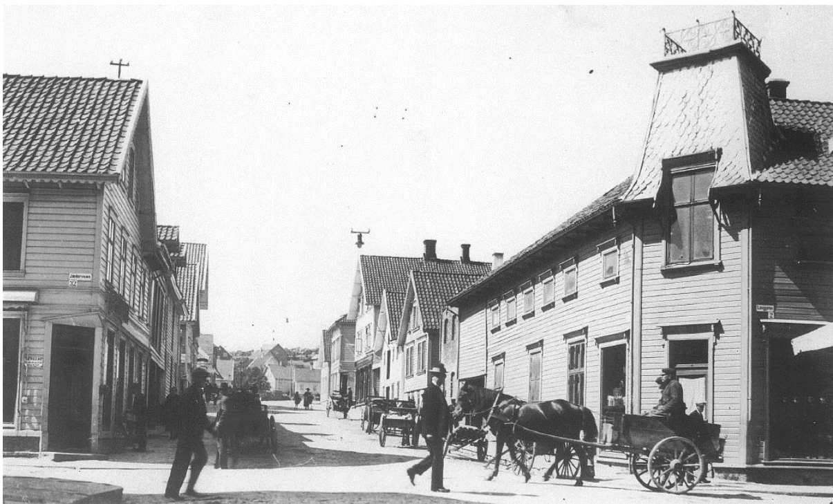
Solaveien vestover fra Krossen. Solaveien som innfartsvei til Sandnes er noe eldre enn Gjesdalveien. Den ble først kaldt Somaveien. Den var ført inn til Postveien i 1838, og videre til Jærveien ca. 10 år senere. Men det var først da den ble koblet til Gjesdalveien sist i 1860-årene, at den ble del av en sammenhengende regional hovedvei. Mye av bebyggelsen vi ser her står fortsatt. (Foto Ludvigsen.)
