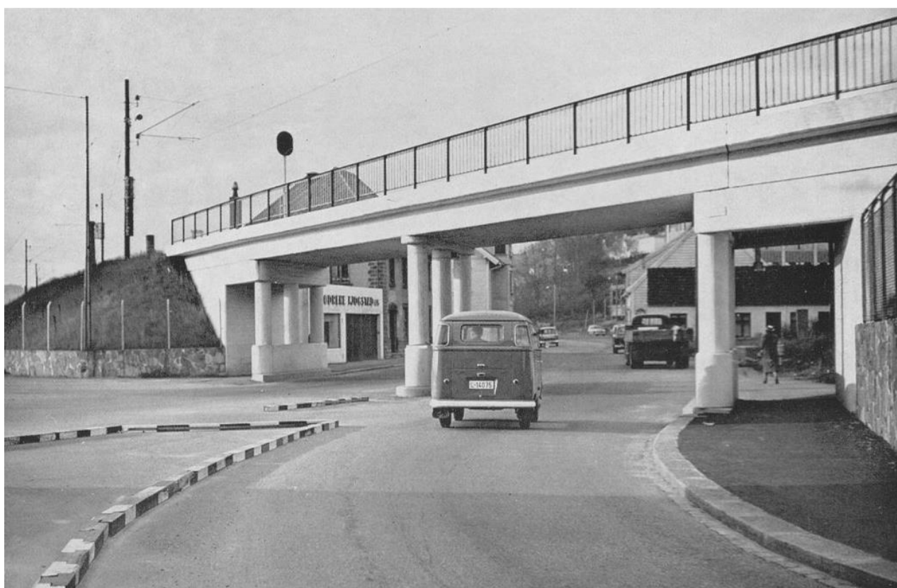
Høybanen som ny, i bro over riksveien ved Kaien, fotografert 1960. Høybanen var et prosjekt med påkostet utforming – skiferkledt murverk, smijernrekkverk og fint formede underganger i moderne stil. Undergangen til hovedveien speiler tidens brytning mellom nyklassisisme og funksjonalisme. Gjennom broa skimter vi Davehuset/Gannhuset som må ha blitt revet like etter at bildet ble tatt. (foto Alf Hobbesland i «Sandnes 1960»).
