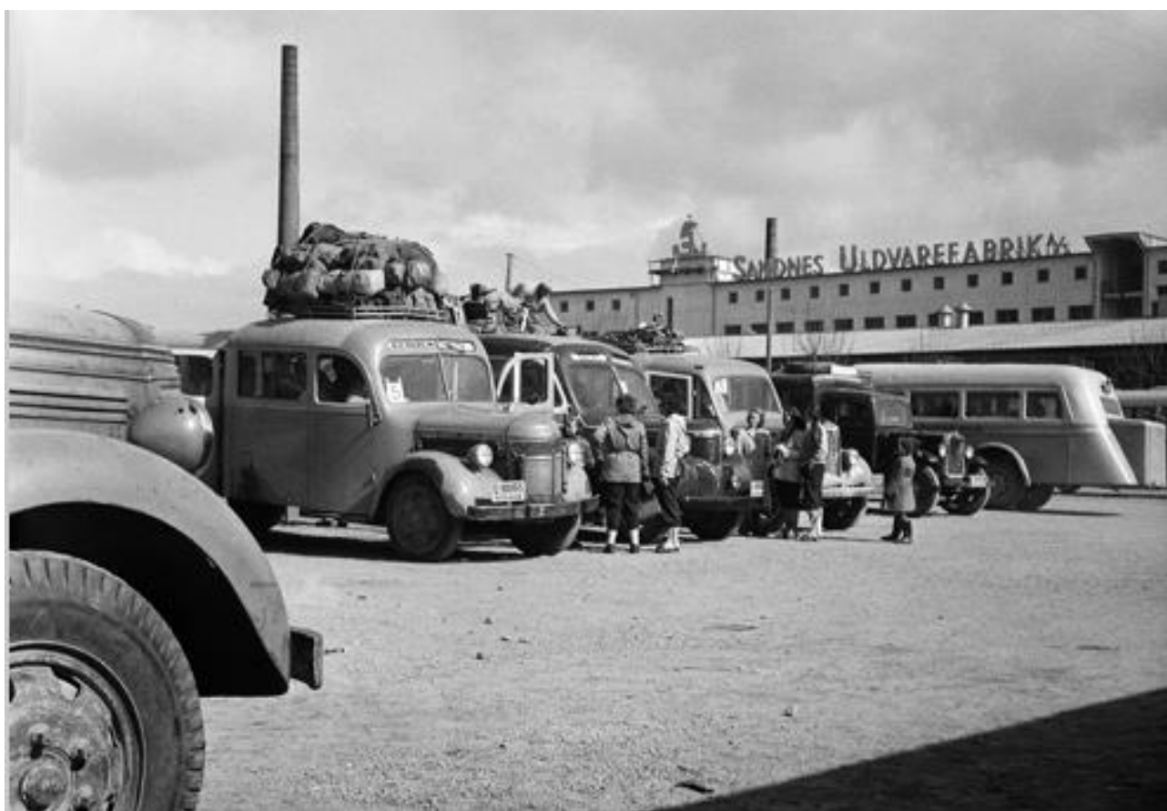
Klargjøring for påskeutfart – i tidlig etterkrigstid? Rutebilene har inntatt sin nye oppstillingsplass i Vågen – tungt lastet for utfart. (Foto Kolbjørn Rostrup)
