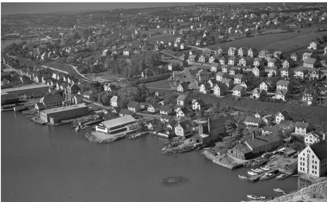
Strandgata fra Simonsbakken til Altona i 1959. Moulandbrygga utnefor Strandgata 76 (huset med høyt valmtak og hage) har fått et moderne næringsbygg. De tre fabrikkbygningene nærmest er Sandnes Preserving til høyre, deretter Simonsens gamle potteri og innerst Sandnes Mølle. Simonsens potteri er erstattet med ny bygning, men de to andre står. I dag sjeldne kulturminner som gjør vesentlig sider av Sandnes-historien lesbar i bylandskapet. Det gjelder også den lille grunnen i sjøen foran med fortøyningssteinen «Hodlen», som forteller at mye av sandnesindustrien vokste fram i et sjøvendt næringsmiljø. (Widerøe, ika-w125099)
