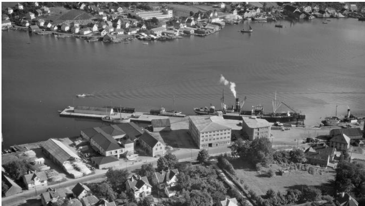
Kaien i 1950. De gamle sjøhusene på Neset er borte, de nye store havnelagrene til Schanche Olsen og Sandnes Dampskipsselskap fra 1933 (på hjørnet) og Ølgænd og Block Watnes delte lager fra 1937, er kommet på plass. Åpningen til venstre for disse markerer Nordre Sjøallmenning. Deretter kommer Brødrene Fjogstads anlegg fra 1933-34. Gjenreist etter en brann i 1933, som tok alle bygningene, untatt ett – en lagerbygning fra 1909 (med gavlen mot Strandgata) – som står i dag også. (Widerøesamlingen IKA, ika-w028413)
