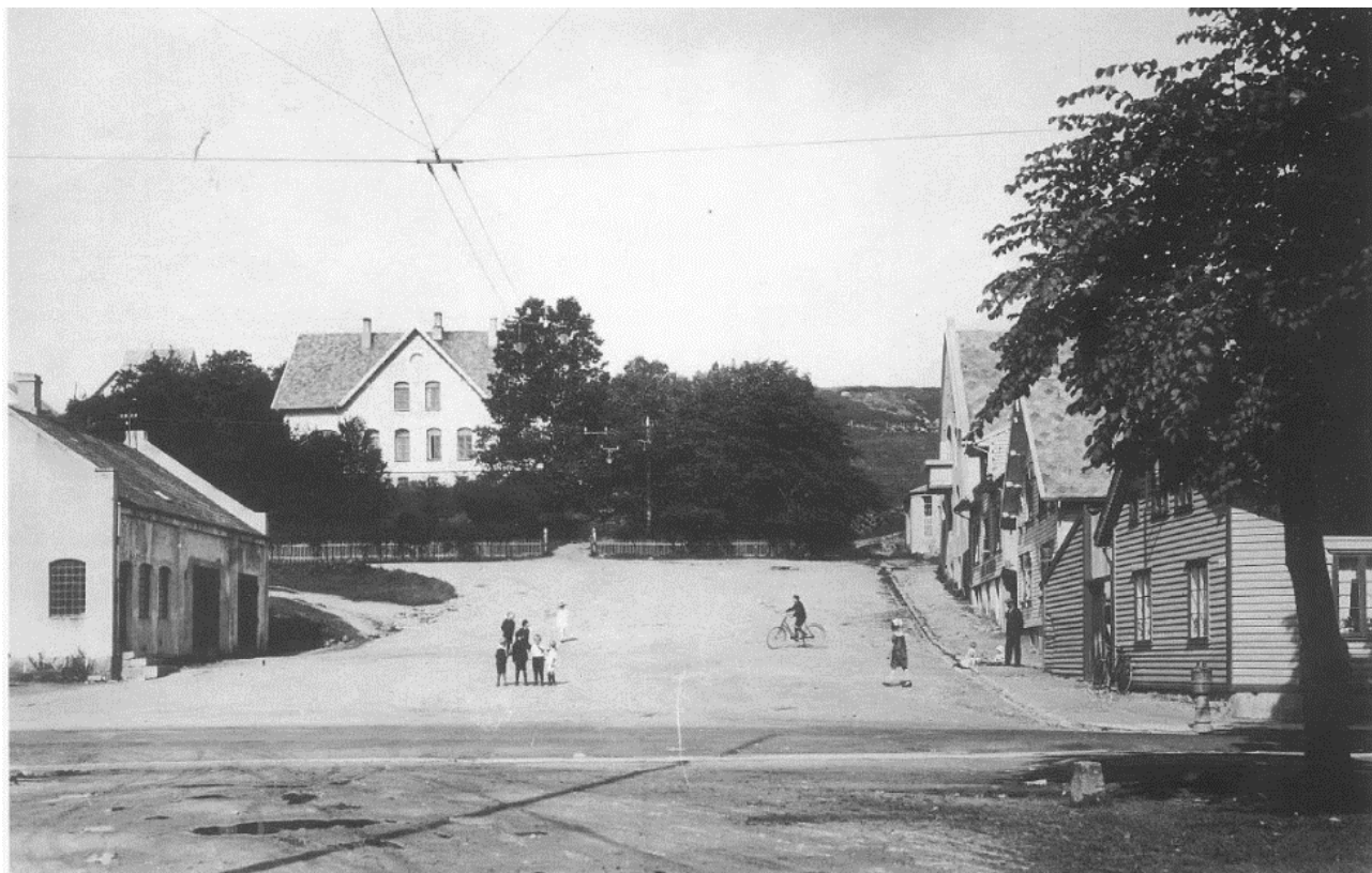
Torvet fotografert rundt 1920, med den gamle brannstasjonen (brannvaktbygningen) til venstre. Sandnes sykehus med park innerst, gavlsneien vi ser øverst til høyre er Frelsesarmeens forsamlingshus (Folkets Hus) og så vidt synligbak denne Folkebadet, Sandnes' offentlige bad, begge fra 1913. Sykehuset ble bygd i 1914 i Samlagshagen, gitt i gave av Sandnes Samlag. Tomten er skrevet inn i matrikkelen som park i 1912. Torvet og parken fungerte som en åpen branngate helt opp til bygrensa. Med noen brudd (sykehuset og Eidsvolls gata) eksisterer psrken fortsatt, og bøketrærne skal i dag være de eldste i Sandnes.
