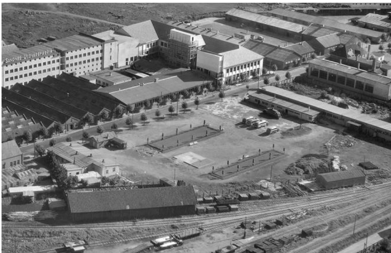
Utstillingsplassen forografert av Widerøe 1950. Bussene har stilt opp. (ika-w028414)
