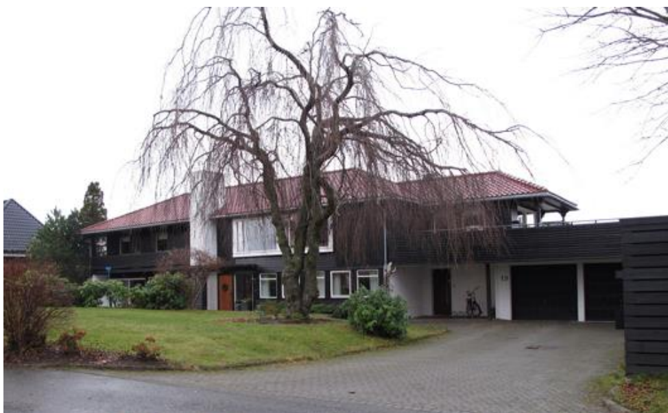
Denne villaen i Alexander Kiellands gate er også et Block Watne hus. Den er typisk for den litt forsiktige, postmoderne trenden på 1970-tallet – kjennetegnet ved det store valmtaket med glasert rød tegl, utvendig skorstein og inntrukken veranda i svalgangform.
