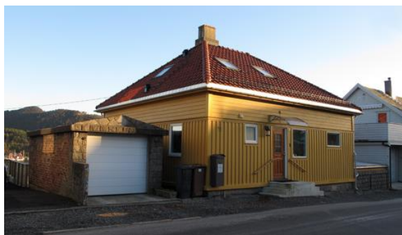
Roald Amundsens gt. 71 med hus fra midten av 1900-tallet. Funkisbungalow med «skjørt- og bluse-kledning» forseggjort garasje med natursteinsfront.
