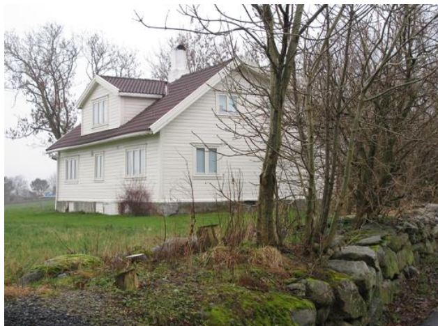
Hovedbygning på Jacobgarden, Søndre Stokka. Bygd ca. 1850, ombygd i 1938.
