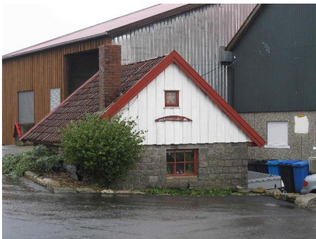
Bryggerhuset på Søndre Stokka har utgangspunkt i et eldre bryggerhus med en blanding av vegger i tørrmurt naturstein og teglstein. Rundt 1940 ble det pusset opp og teglmuren erstattet av tilhogd naturstein i fint fuget mur.
