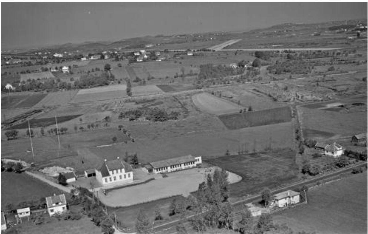
Området ved Lura skole (1933) fotografert av Widerøe i 1956. (ika-w093960)
