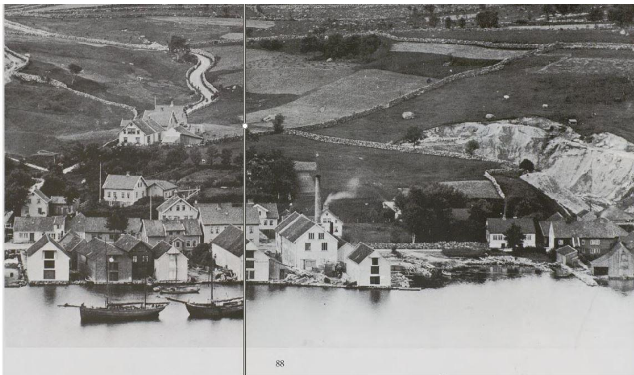
Tronesveien ses bak Sandnes Høvleri. Leirbanen til Nynæs til høyre. (Bildekilde: Sandnes 1. «Bilder fra gamle dager» Sandnes 1998.)
