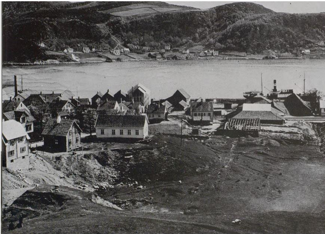
Salem og verkets ovnshus sett fra leirbanen, ca. 1935. Fra Sandnes 1. «Bilder fra gamle dager» Sandnes 1998.
