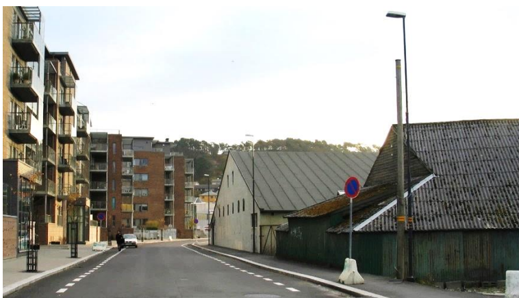
Havnegata med «Verk nr. 4» til høyre og fjernlagret lagerhus nærmest.
