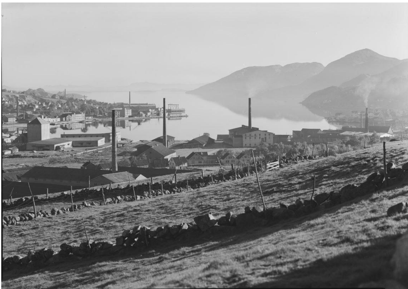
Gandsfjorden med Graverens teglverk sett fra Austrått.
