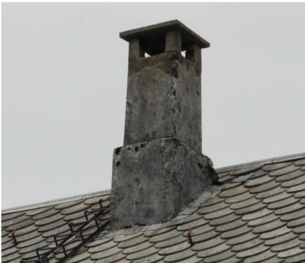
Original taktekking og pipe på bolighus fra 1930-tallet.
