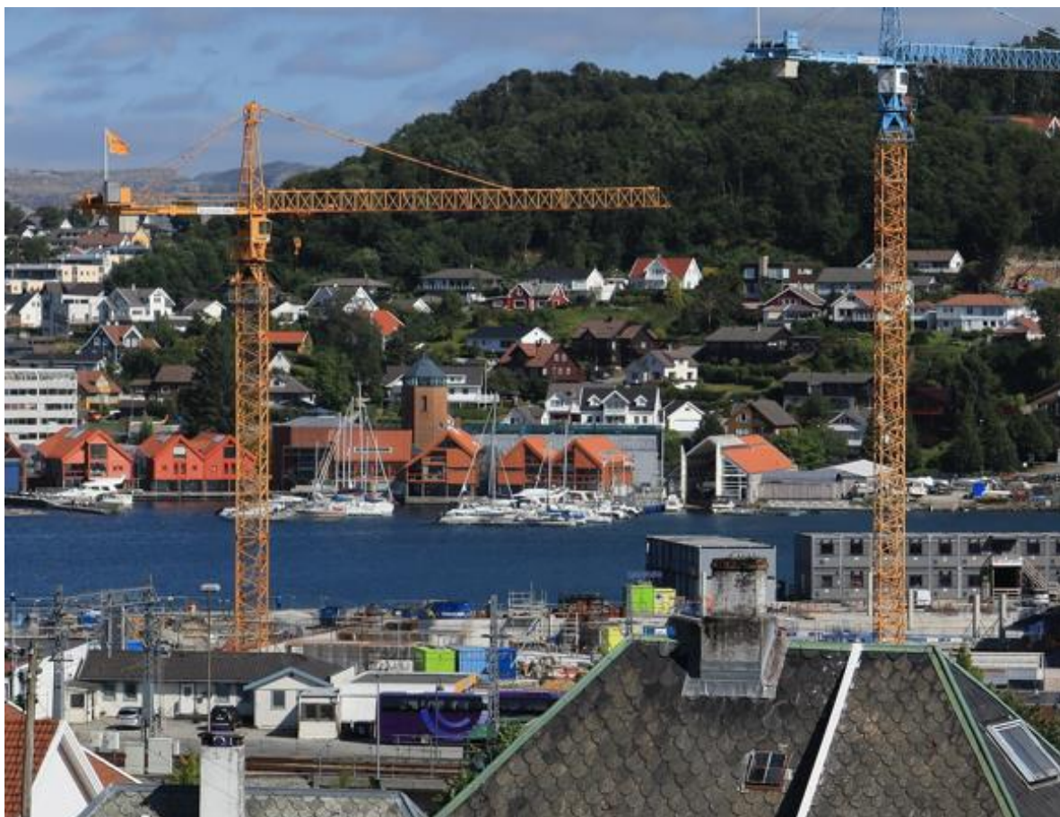
Utsikt fra Blåsenborg mot Hana 2018. Transformasjonen av sjøfronten inne i Vågen startet med Hanabryggen e midt på 1980 tallet. Kranene viser utbygging av ny sentrumsbebyggelse i indre havn, der bl.a. Sandes nye rådhus står i dag.
