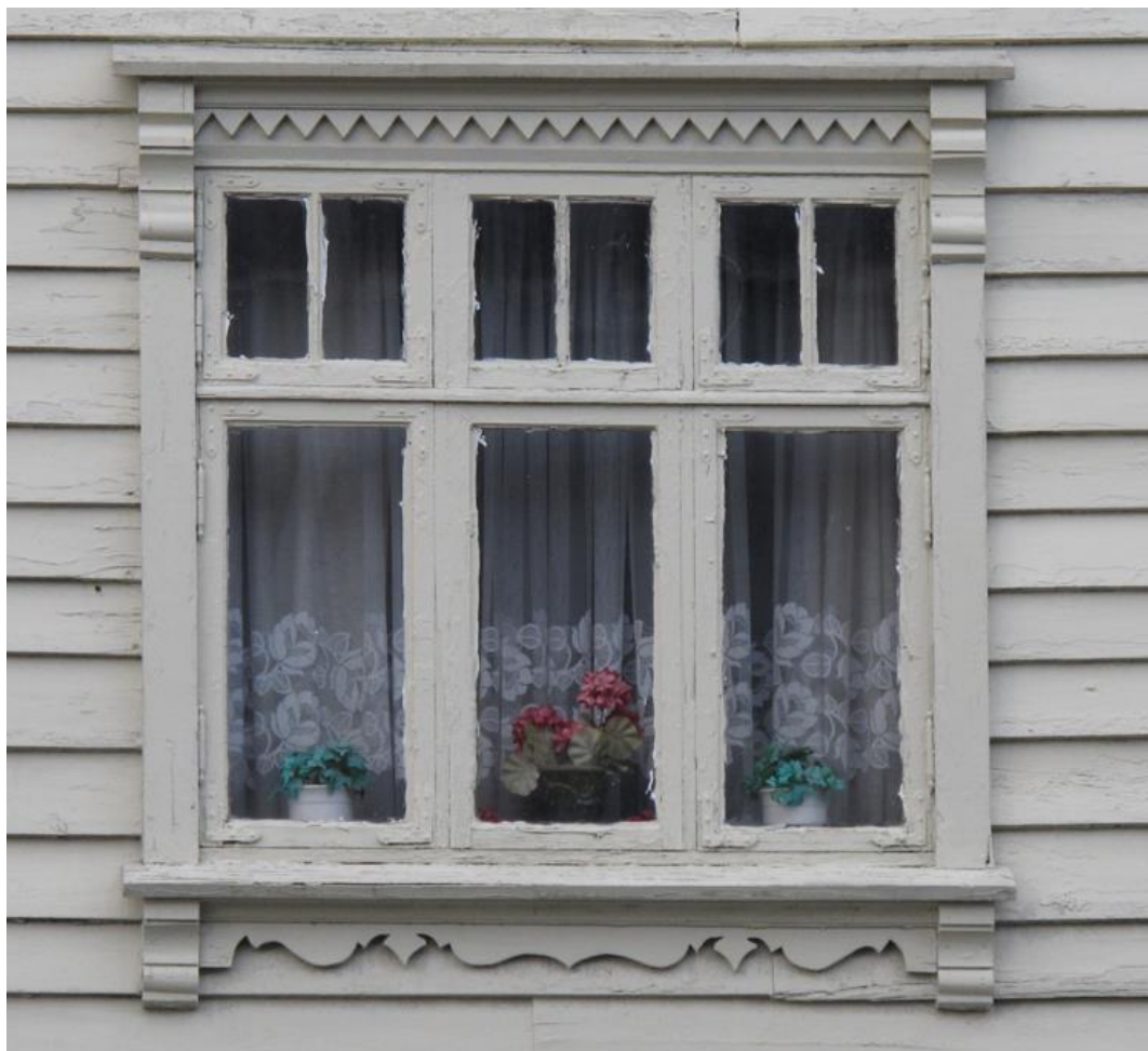
Trefagsvindu i Strandgata 22
