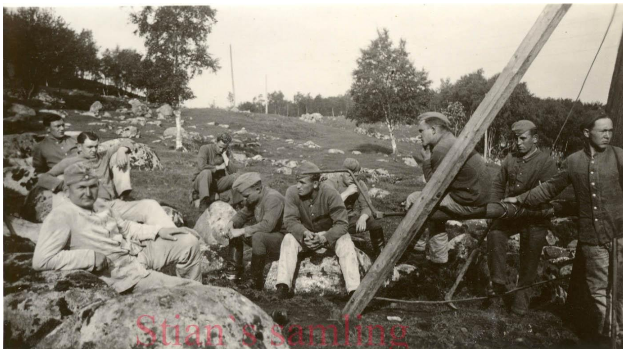
Tyske soldater har pause. Det var tyske soldater som begynte anleggsarbeid i Vatneleiren. I 1941 overtok russiske krigsfanger.
