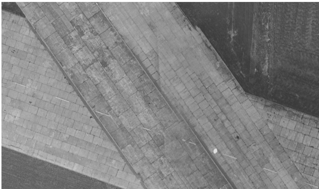
Rullebanene på Forus flyplass fotografert i 1955. Rullebanene ble bygget med betongplater.
