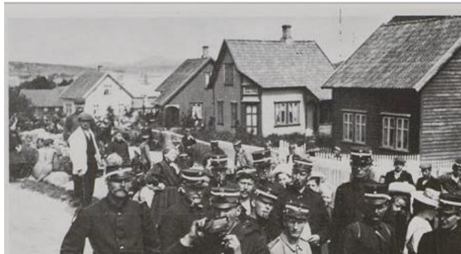
Feltmanøver på Hana 8. juli 1908. Huset med avkortet hjørne er Skippergata 36 som Emanuel Simonsen bygde i 1908 – i kubbekonstruksjon av plankestomper tatt hit som ballast fra sagbrukene østpå. (Bildekilde Sandnes 1. 1998
