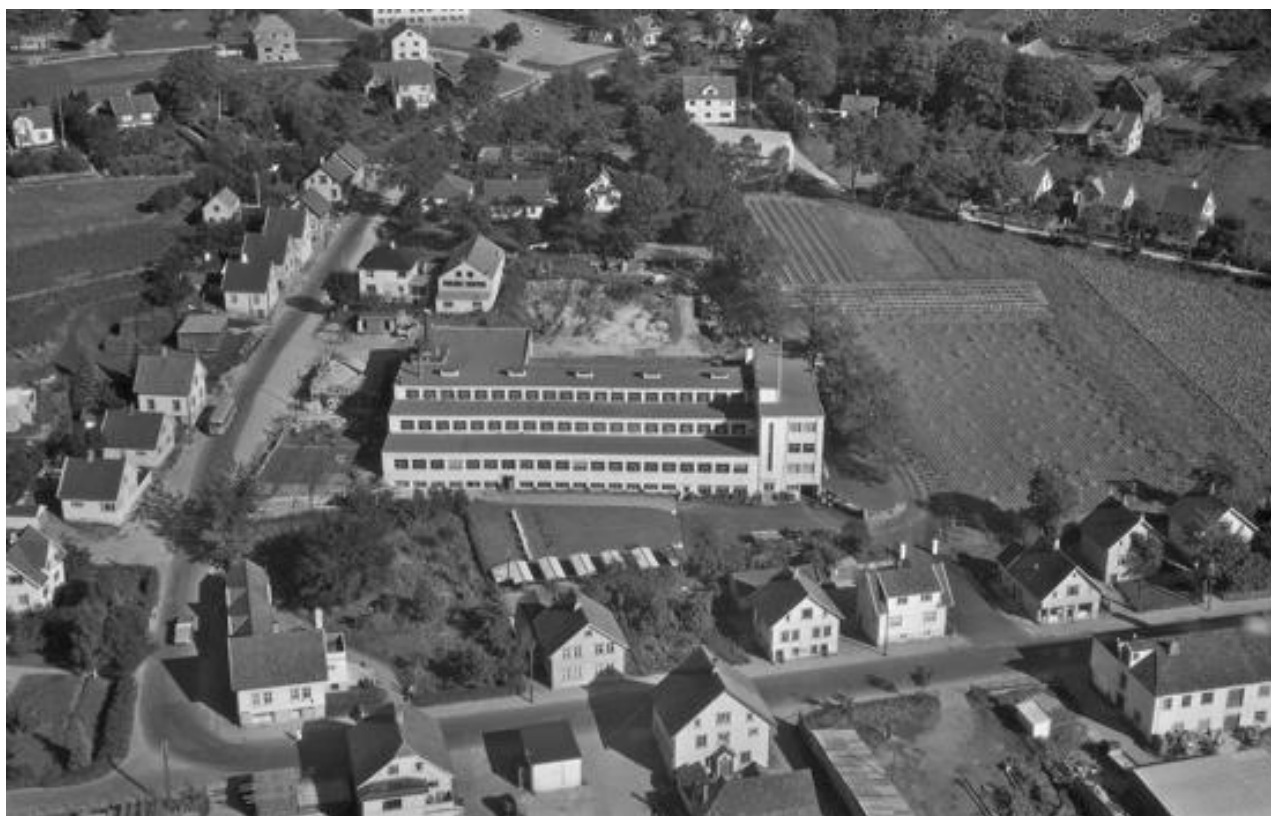
Aducerverket fotografert av Widerøe i 1950. På omgivelsene kan det se ut som utbyggingen er under forberedelse. Verket ligger rett foran Futegarden som skimtes gjennom trærne i hagen. Ennå står alléen som gikk fra Futegarden ned mot Hanaveien. Husrekka langs Hanaveien er i dag borte, den langs Skippergata er intakt. (foto ika-w028418)
