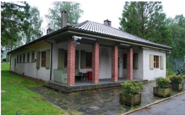
Vaktpost og arrest ved inngangen. Utforming inspirert av 1700-tallets corps de gardes på festningene.
