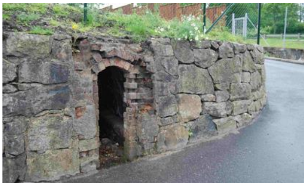
Vaktpost bygd inn i mur ved den opprinnelige innkjøringsporten.
