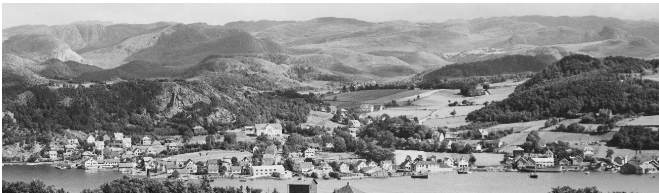
Hana fotografert i 1947. Alle de gamle industriene er i sving, men det er før Aduscerverket fikk opp sine bygninger. (Mittet & Co AS, Nasjonalbibliotekets bildearkiv.)
