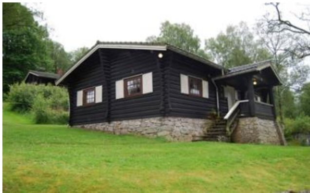
En av fem befalsforlegninger i Norges best bevarte «Waltlager», etter typetegninger utarbeidet av Organisation Todt.
