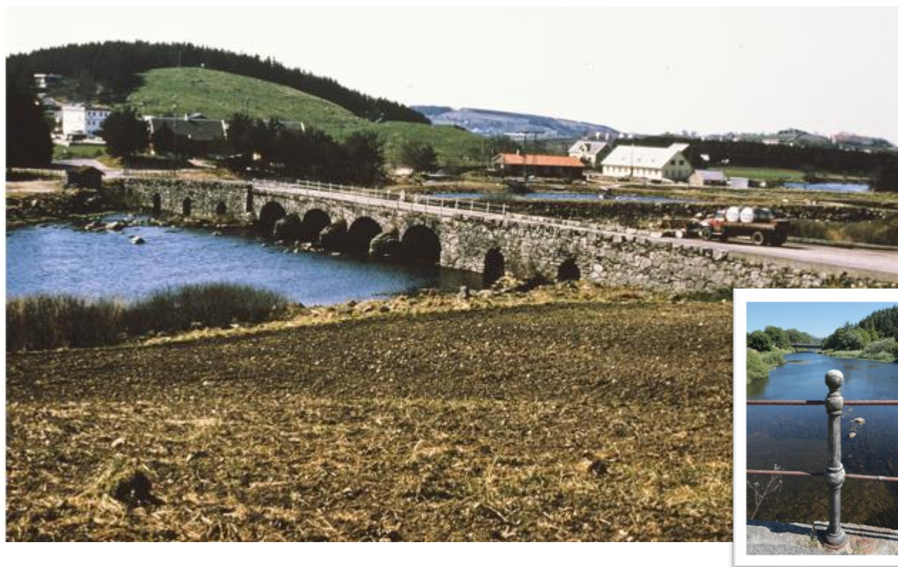
Skjævelandsbrua sett fra nord. Brua ble tegnet av Ingebrikt Mossige, veiinspektør og lensmann i Time. Den ble bygd av Gabriel Høyland også fra Time. Ole Olsen Skjæveland gjorde smedarbeidet, hovedsakelig rekkverket. Den er en steinbru bygd som en kombinasjon av hvelv- og hellebru. Løpene i midten har fire store, klassiske hvelv, som er flankert av 6 mindre åpninger som kalles huldiker. De er såkalte falske hvelv laget av utkragende steinheller lukket av en steinhelle øverst. Brukarene er forsterket av «isbrytere» og bunnen i elva dekt av heller. (Udatert foto i Digitalt museum: Sf23009)
