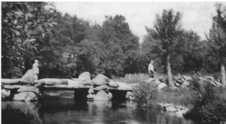
Hellebrua av stein, som krysset Storåna ved Steinbru på Lunde, ble revet sist på 1960-tallet. (Bildekilde Lions 2017:11)
