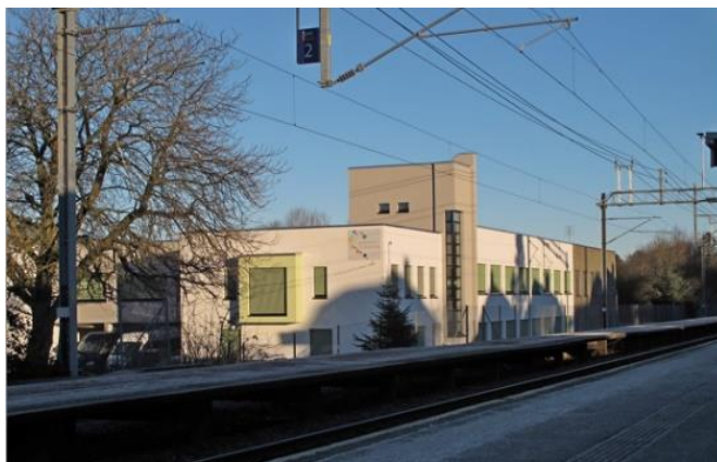
Ganddal Møbelfabrikk (1919) er bygd om til skole. Den er pusset opp på en måte som tar vare på stilpreget fra funkisperioden, og som gjør det lett å knytte huset til historien som en av de ledende møbelfabrikkene på Ganddal midt på 1900-tallet.
