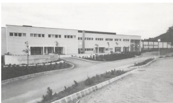
Ullvarens anlegg på Foss-Eikeland i mai 1987. Lars Øglænd var arkitekt og AS Betong entreprenør. (Bildekilde (Kilde HB 1989
