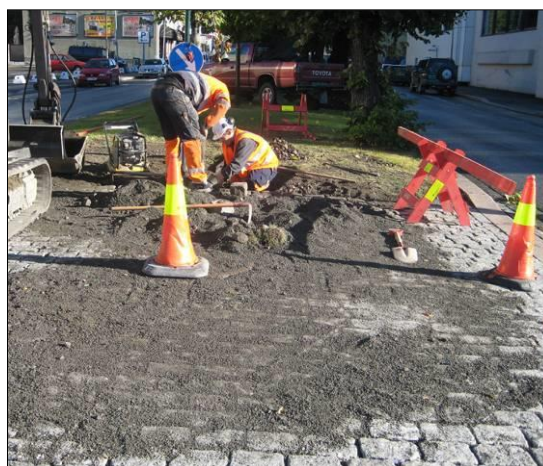
Etterfuging av brosteinarealer.
