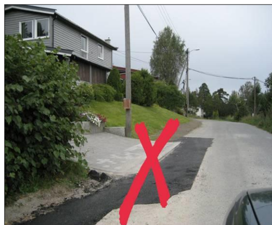
Uønsket endring av grøftetrasé
