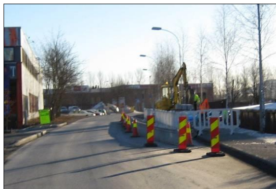
Riktig utført sikring og varsling.
