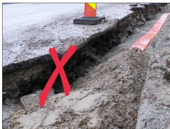
Utrasing av grøfteside. Her må det foretas skjæring av asfalt og justering av grøfteskråning
