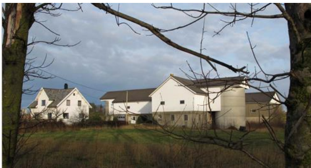
Gårdstun på Malmheim til venstre, med tidsenhetlig bebyggelse fra rundt 1930. Tilbygde siloer i lengden. Stor driftsbygning på Lea til høyre, med støpt fjøs og kjeller og sammenhengende bindingsverksløe over. Eldre forhøyede siloutbygg på langsida. Typisk for etterkrigstidens driftsbygninger.
