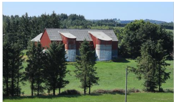
Gårdstun på Malmheim til venstre, med tidsenhetlig bebyggelse fra rundt 1930. Tilbygde siloer i lengden. Stor driftsbygning på Lea til høyre, med støpt fjøs og kjeller og sammenhengende bindingsverksløe over. Eldre forhøyede siloutbygg på langsida. Typisk for etterkrigstidens driftsbygninger.
