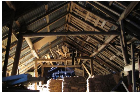
Løe på Malmheim med grindverk som takbærende konstruksjon. I dag et av svært få hus med grindkonstruksjon i flatbygda.
