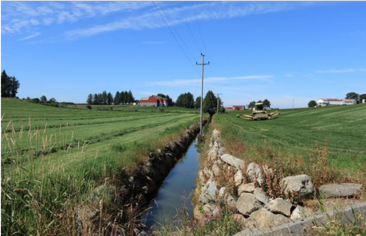
Leakanalen ble gravd 1915.
