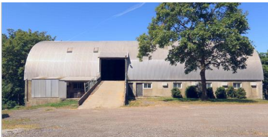
«Amerikansk løe» på Heigre, bygd i etapper på 1960-tallet. Som en del av Marshallhjelpen etter krigen dro norske landbruksmyndigheter på studietur for å se på bl.a. amerikanske landbruksbygninger. Med hjem hadde de nye takkonstruksjoner bestående av limede lameller i runde former, som gav store åpne forrom. Blant en håndfull amerikaløer i Sandnes er løe på Heigre den best bevarte.
