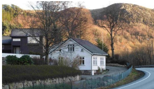
Bebyggelsen til bruk 15 på Bråstein er et av få med bebyggelse ved den gamle hovedveien mot Ålgård, i dag del av E39. Huset er bygd rundt 1900. Til bruket lå en beinmølle ved Figgjo.
