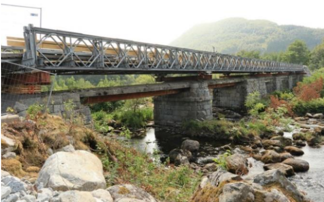
Bru over Figgjo, Åslandsveien ved Mjøgedal.
