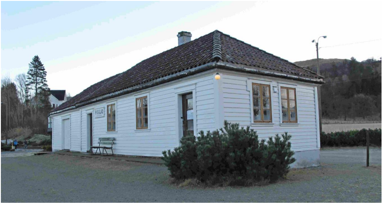
Ekspedisjonsbygningen på Figgjo stoppested ble bygd til åpningen av Ålgårdbanen banen i 1924. Den er tegnet av arkitekt R. Werenskiold ved NSB's arkitektkontor i nyklassisk stil. Ålgårdbanens Venner ble dannet i 2004, og har etablert et lite jernbanemuseum i huset.
